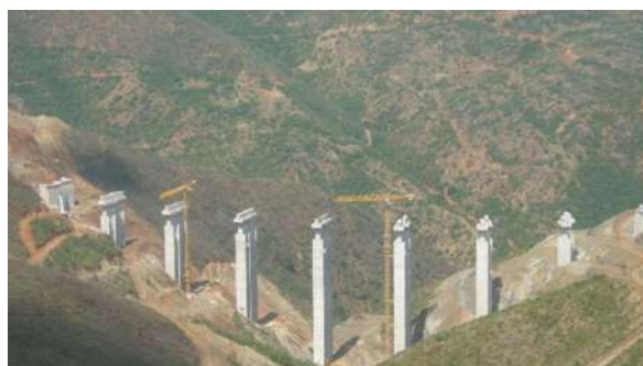
Fig. 1-10 Foto gjatë ndërtimit të urave në rrugën Durrës – Morinë (A.Lako)
