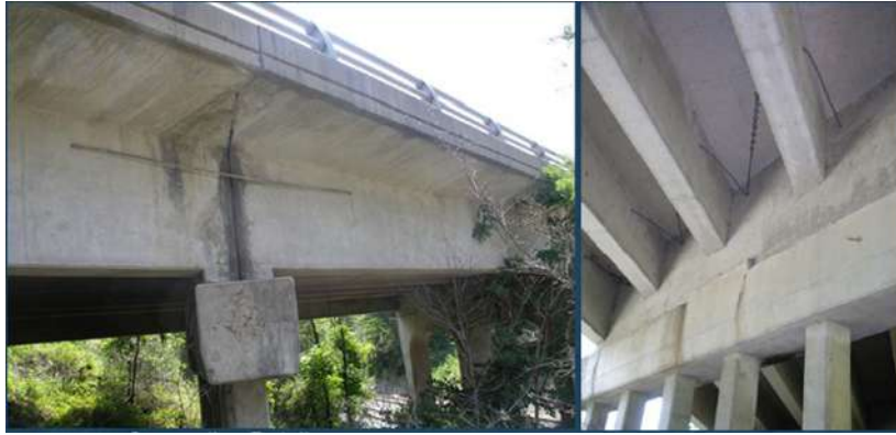
Fig. 2-1 Kavot e kufizimit në urat me mbështetje të thjeshtë, detaje lidhës
