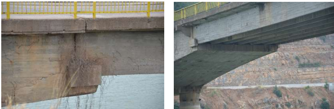
Fig. 5-55 Foto të fugave në mbështetjen e trarëve dytësorë në ballna dhe në konsola
