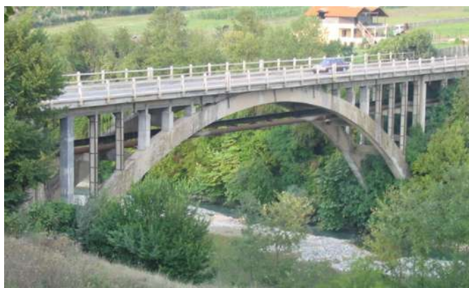
Fig. 1-11 Përforcimi i kolonave në urën e Zenishtit në Burrel, (A.Lako)
