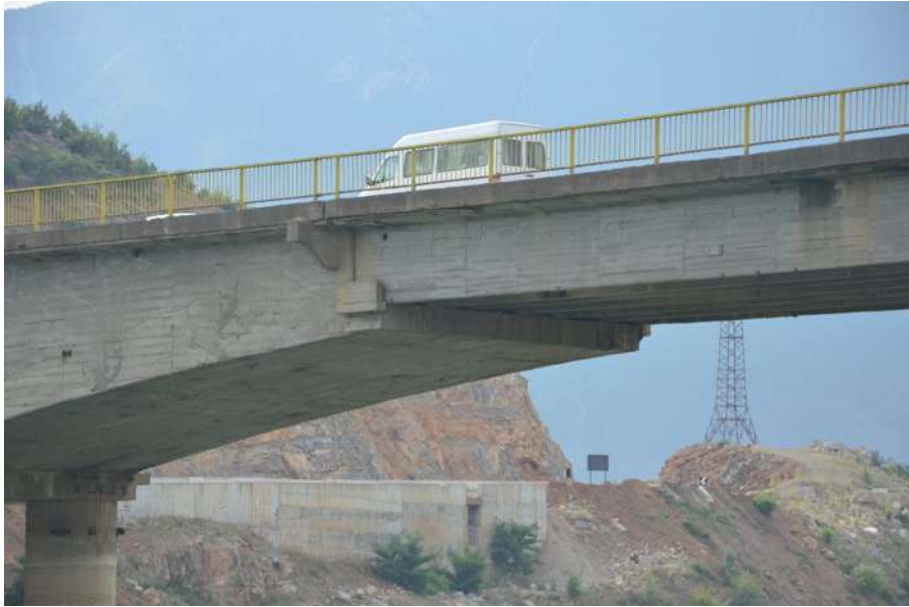
Fig. 5-9 Foto e mbështetjes së trarëve dytësorë në konsola (A. Lako, 2013)
