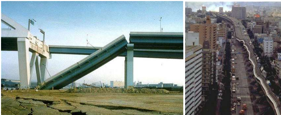
Fig. 1-2 Ura Nishinomiya-ko dhe viadukti Hanshin (Ekspressway) Japoni Kobe 1995. 3
