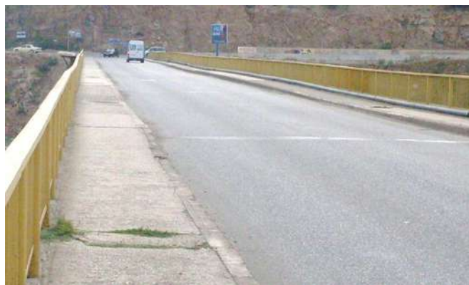
Fig. 5-56 Foto e pjesës kaluese të urës, hapësira e fugave e asfaltuar
