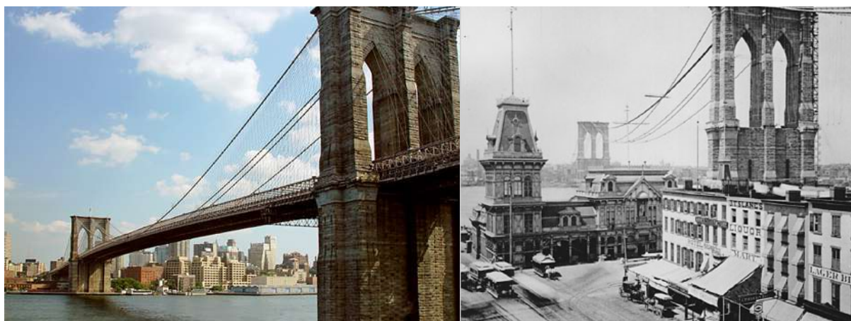
Fig.3.6 Majtas – Brooklyn Bridge, 1883, John Roebling; djathtas – detaj gjatë ekzekutimit, ku mund të shihen pilonet nga muratura dhe litarët kryesorë (kabllat).
