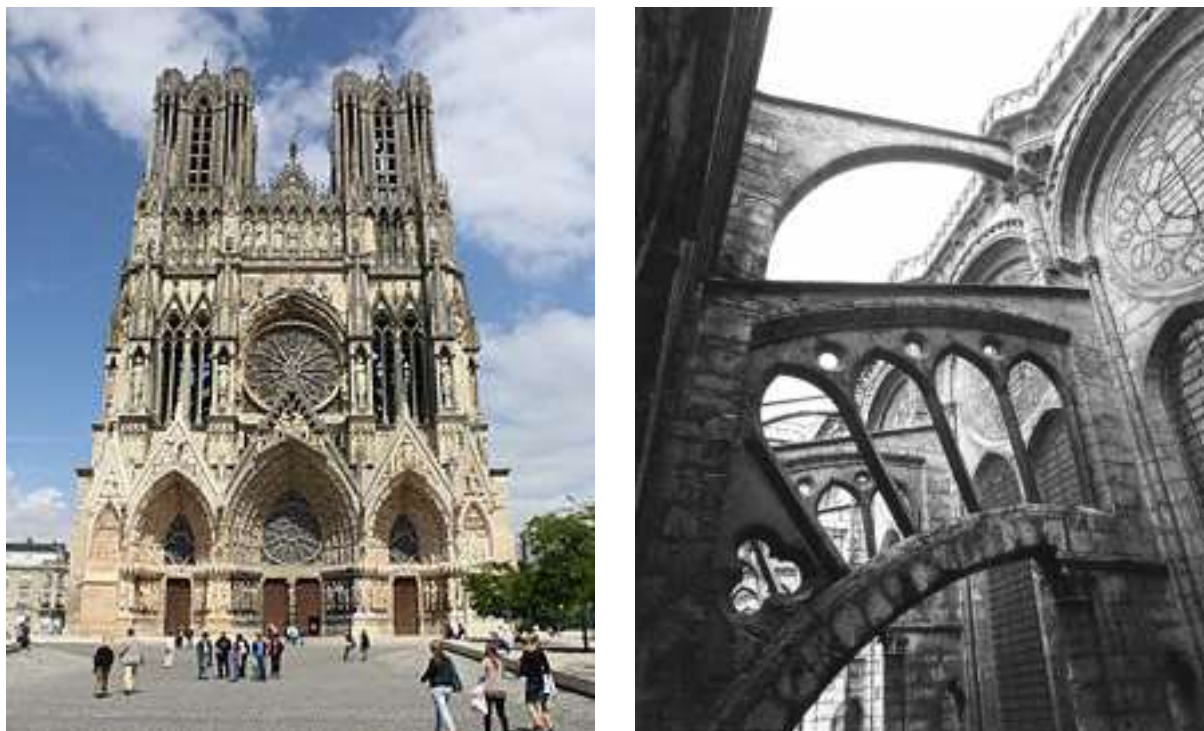
Fig. 3.2 Majtas – Notre-Dame de Reims , ~1211 AD, qyteti Reims, Francë; djathtas-harqet e fasadës për shkarkimin e komponentës horizontale të shtytjes së harkut.
