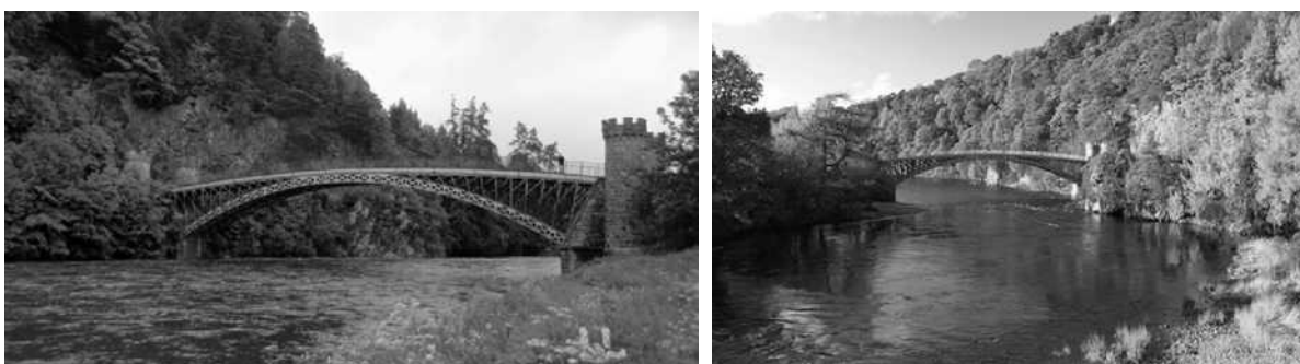
Fig. 3.13 Craigellachie bridge , Thomas Telford, Craigellachie, Skotlandë, 1812 – 1814, l = 50m [22] – një kryevepër arti.
