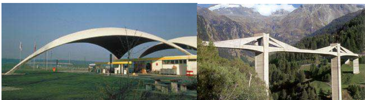
Fig. 3.10 Majtas – Pompa e benzinës në Deitingen, Heinz Isler, 1968; djathtas – Ganterbrücke, Simplonspass, Switzerland, Christian Menn, 1980; dy kryevepra të artit të strukturave.
