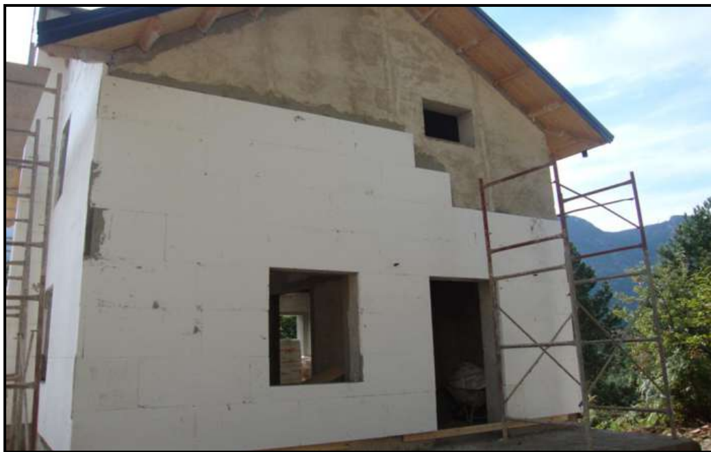
Figura 4.4. Pamje nga procesi i montimit te sistemit tip “ Kapot” ne vilen e pare 2 kateshe .
