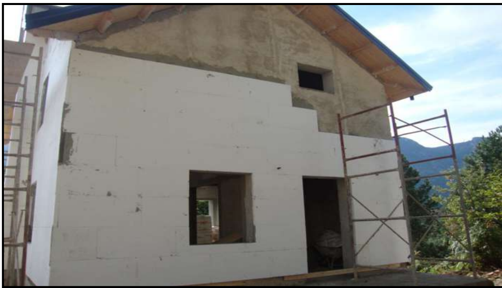
Figura 2.4. Pamje e nje vile 2 kateshe ne procesin e termoizolimit tip “Kapot”
