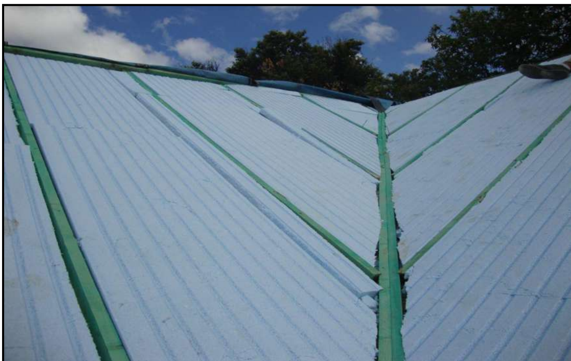
Figura 4.7 Pamje nga termoizolimi i catise ne vilen ne Qafe Molle
