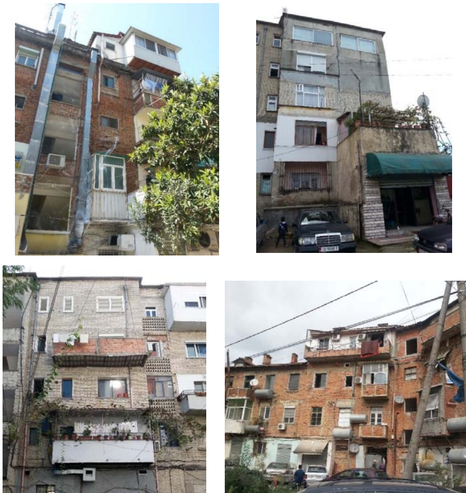
Figure 2.19 – Ndërhyrjet në strukturat me muraturë (foto autori nga objektet në Tiranë)
