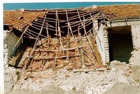
Figura 2.6 – Dëmtim i shkollës për shkak të një plani rrëshqitjeje të pa konstatuar më parë(foto autori:Shkolla Gurrë, Tiranë)
