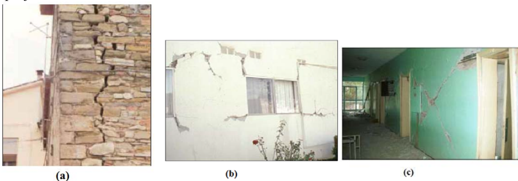
Figura 2.22 – Çarje vertikale tek bashkimi i murit gjatësor dhe tërthor (a) dëmtim nga forca prerëse (b) dëmtim diagonal i murit (c) (foto [31])
