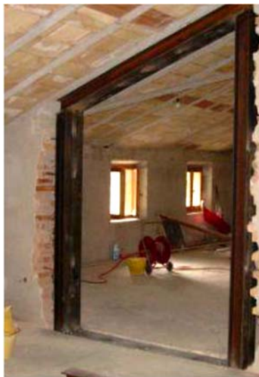
Figura 3.11 – Përforcimi me element metalik për hapjet[8]
