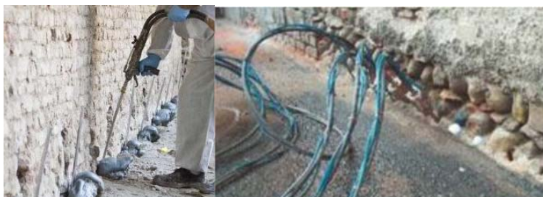
Figura 3.12 – Injekttime me llaç të cilësisë së lartë[8]
