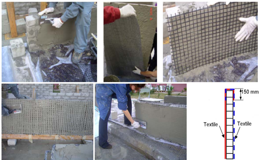
Figura 3.24 Aplikime praktike të teknikës TRM (Construction and Building Materials, 2011) [20]
