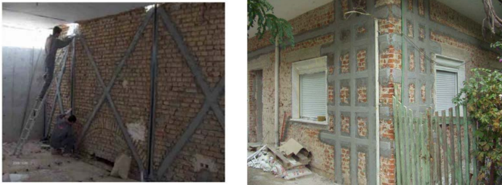
Figura 3.20 – Aplikime të përforcimit me FRP të strukturës me muraturë(www.angelobiondi.com) [8]
