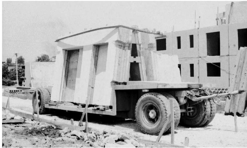
Figura 3: Transporti i paneleve në kantier (Burimi: Arkivi qendror teknik i ndërtimit)
