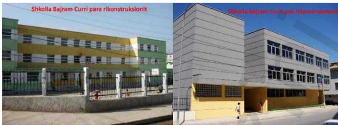
Figura 53. Shkolla Bajram Curri, Tiranë, përpara dhe pas rikonstruksionit. Viti i Ndërtimit 1970 dhe ai i rikonstruksionit 2003-2006. Ark: V.Islami, E.Kasimati, N.Theodhosi.
