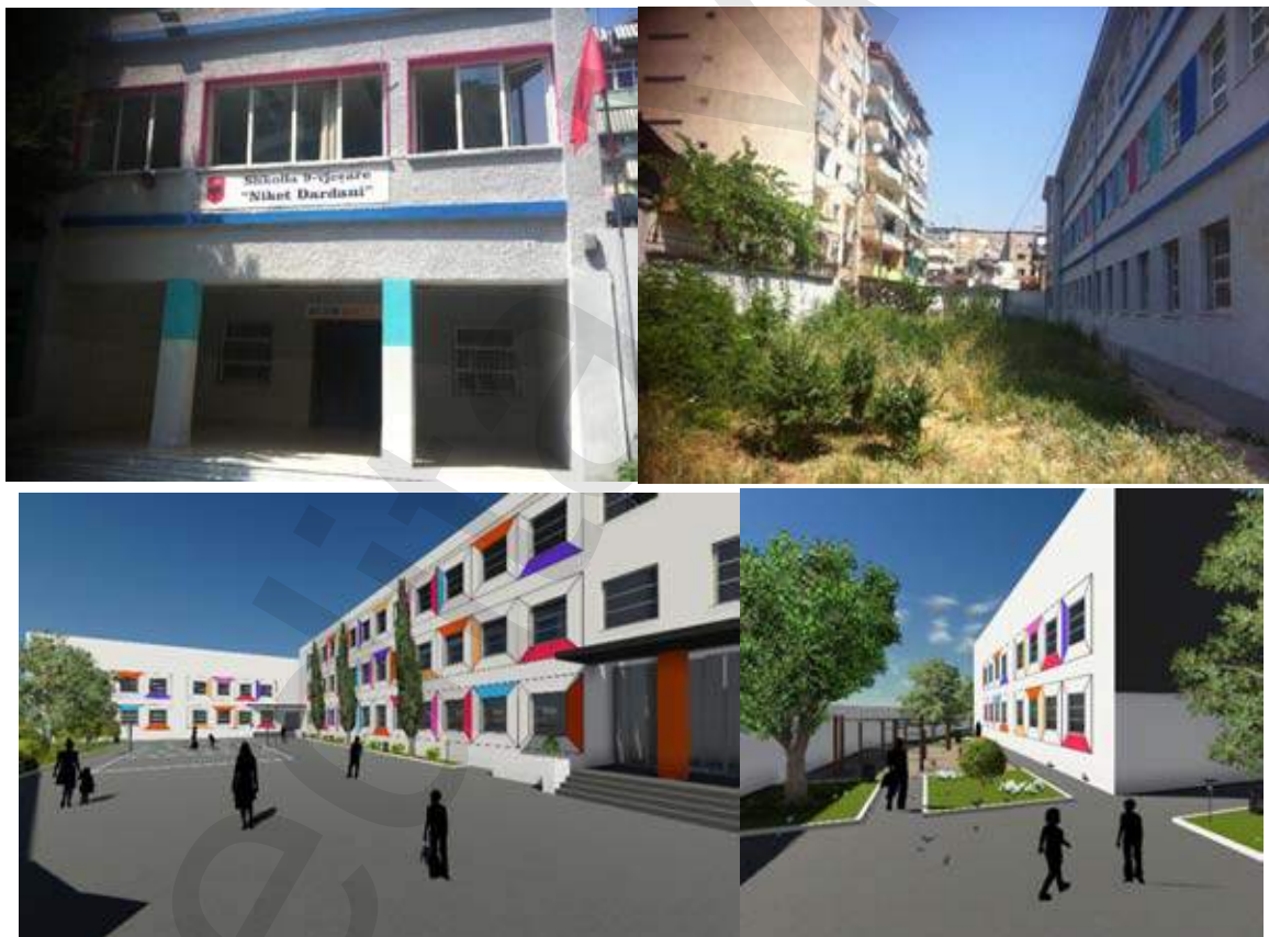
Figura 58. Majtas-Sipër: Pamje e momentit të hyrjes në shkollën 9-vjeçare Niket Dardani përpara rikonstruksionit. Djathtas sipër: foto të gjendjes ekzistuese së oborrit të shkollës. Poshtë: Imazhe të shkollës sipas projektit të rehabilitimit.
