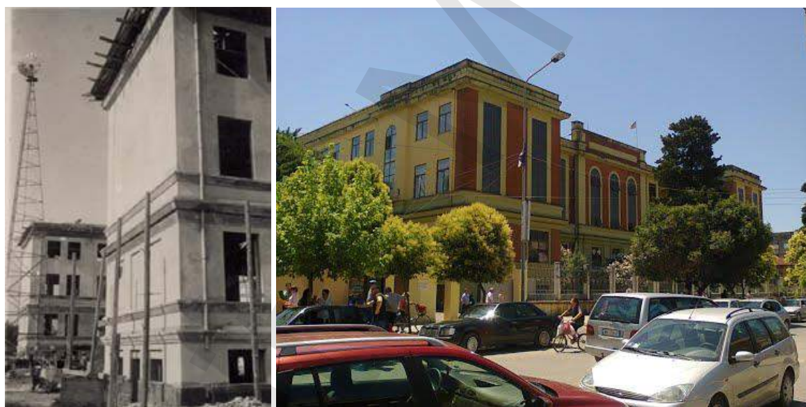
Figura 108. Pamje gjatë ndërtimit të dy krahëve të godinës së Shkollës industriale të Artit në Shkodër dhe foto e gjendjes ekzistuese. Burimi: Armand Vokshi
