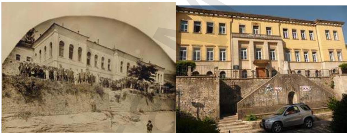
Figura 101. Pamje e Liceut të vjetër të Gjirokastrës përpara se të ri konstruktohej nga Italianët dhe foto e gjendjes ekzistuese.
