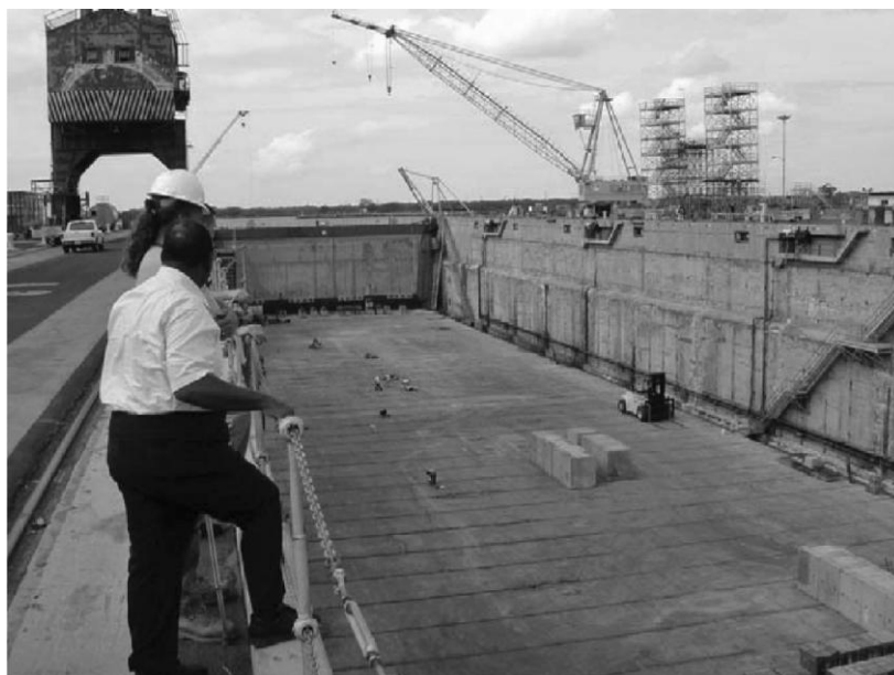
Fig. 1.5 Riparime betoni të armuar me GFRP në kantierin e riparimeve të anijeve (Pearl Harbor)
