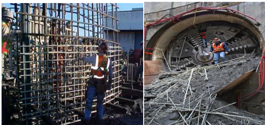
Fig. 1.12 Përdorimi i armaturës GFRP në “soft eye” dhe thyerja nga TBM
