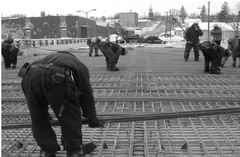
Fig. 1.6 Soletë ure betoni të armuar me GFRP (Quebec, Kanada)
