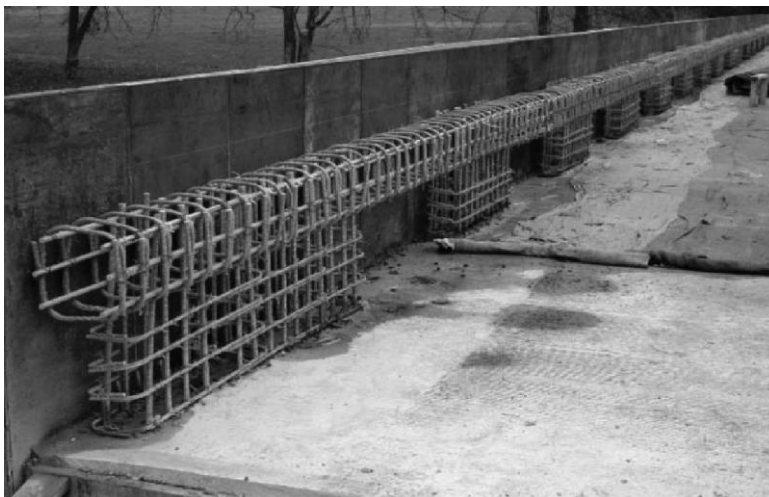
Fig. 1.7 Armaturë GFRP para betonimit të parapeteve të urës (Missouri, USA)
