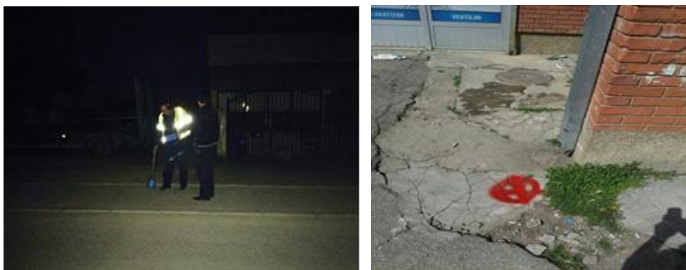
Figura 1.6 Detektimi i vendit të rrjedhjes-lokalizimi i vendrrjedhjes
