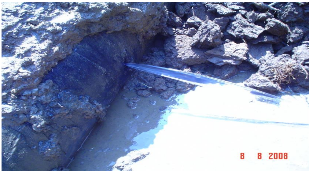
Figura 2.8 Rrjedhja në tubin transportues DN-800mm-FPU-Badoc
