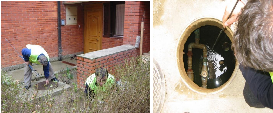
Figura 2.12 Detektimi i rrjedhjeve nga tubat sekondarë të konsumatorëve
