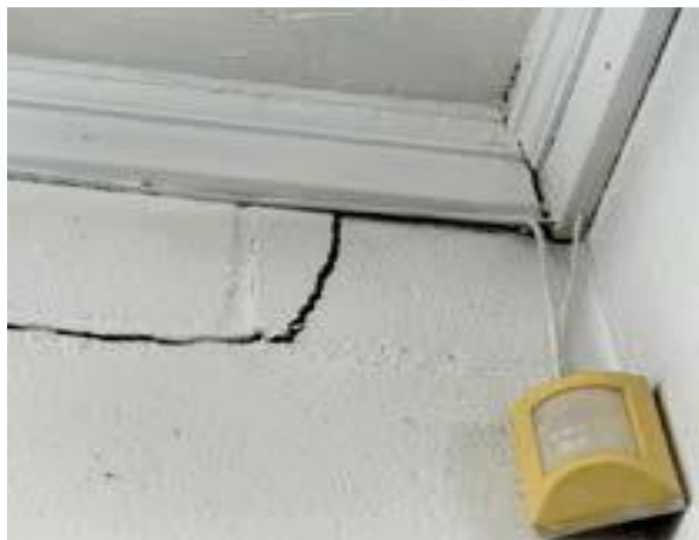
Figura 3-13 Çarje në një strukturë për shkak të vibracioneve të terrenit pas një shpërthimi të detyruar
