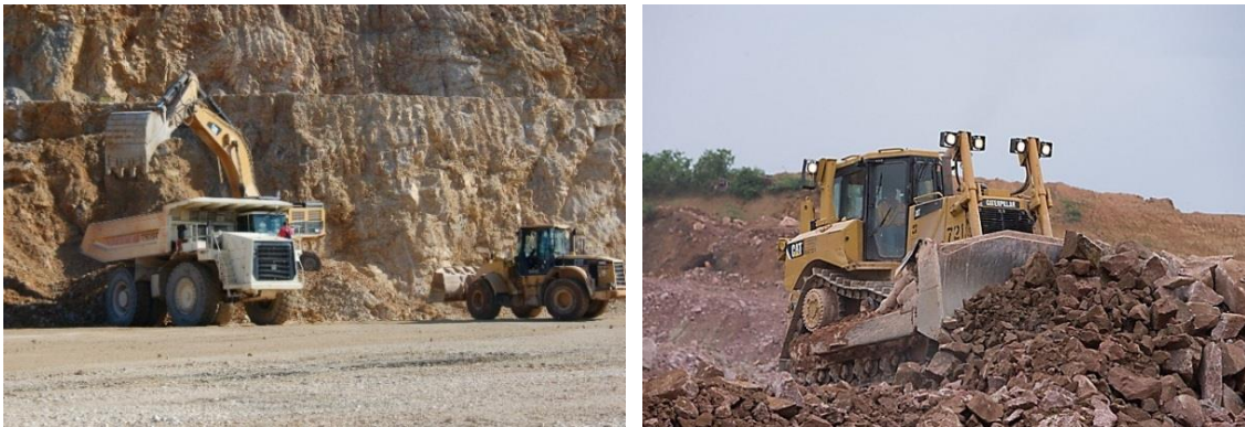
Figura 6-17 Ekskavatori 385C & buldozerit D8T Catërpillar 950G në momentin e punës
