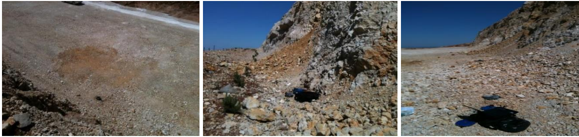
Figura 7-33 Instalimi i instrumentit të monitorimit të dridhjeve gjatë shpërthimit
