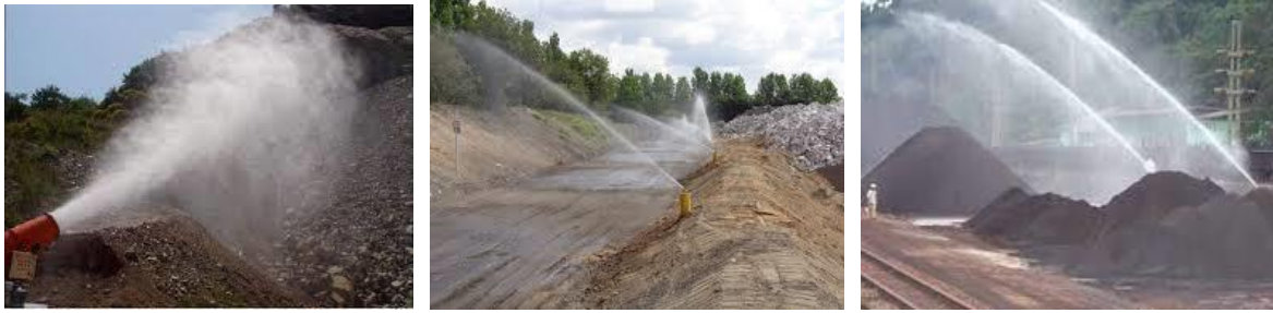
Figura 7-57 Mënyrat e spërkatjes me ujë e frontit të punes dhe stoqeve, për eliminimin e pluhurit
