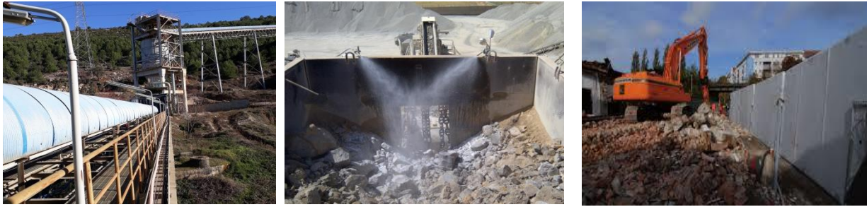
Figura 7-48 Foto, Përdorimii elementëve të ndryshëm për uljen e zhurmës dhe pluhuri
