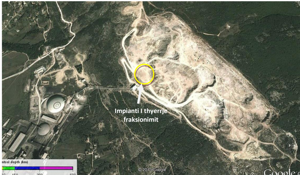
Figura 7-56 Impianti i thyerrje - fraksionimit të gurit gëlqerorështë vendosur në një ndërtesë të posaçme.
