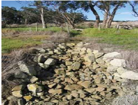
Figura 7-30 Gurët e rreshtuar në pikën shkarkimit të ujit sipërfaqësor për të parandaluar erozionin.
