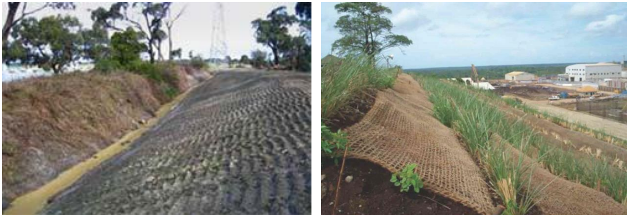
Figura 8-3 Rehabilitimi i sipërfaqes së karrierës, me rrjetë kryqe dhe hidrombjellje.
