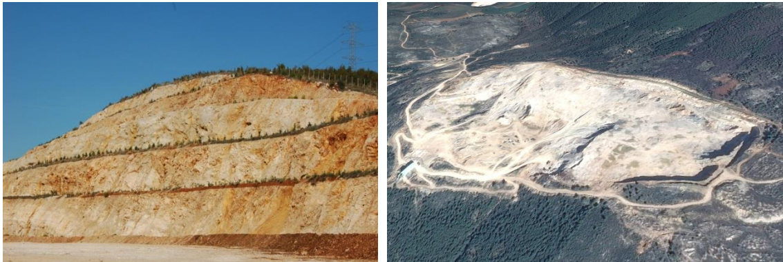
Figura 8-7 Foto, Rehabilitimi progresiv i realizuar në karrierat e vendit tonë (Borizanë & Fushë Krujë).
