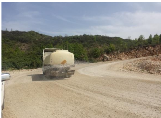
Figura 3-7 Spërkatja e rrugëve të transportit dhe impiantit të thyerrje fraksionimit me ujë.
