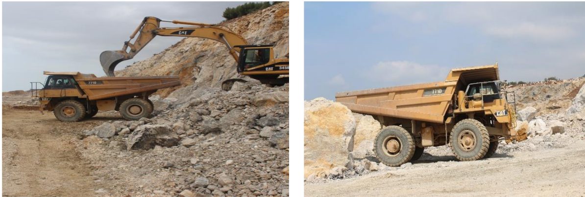
Figura 7-47 Foto, Pajisjet e ngarkimit dhe kamionët e transportit në shkallën e karrierës
