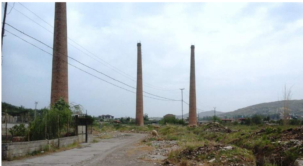
Foto 9. Impianti i distilimit të naftës sipas teknologjisë së re (AVTII)
