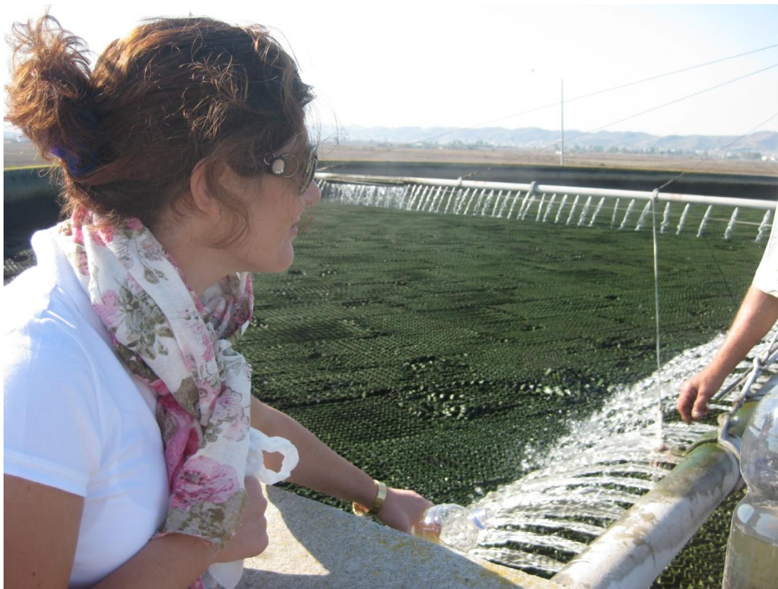
Figure 4.2 Moment i marrjes së mostrës në filtrin biologjik të llojit me pikim në ITUNU në Kavajë
