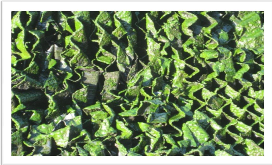
Figure 5.10 Foto e Biofiltrit (filtrit me pikim) me ngjyrë të gjelbër për shkak të pranisë me shumicë të algave fijëzore
