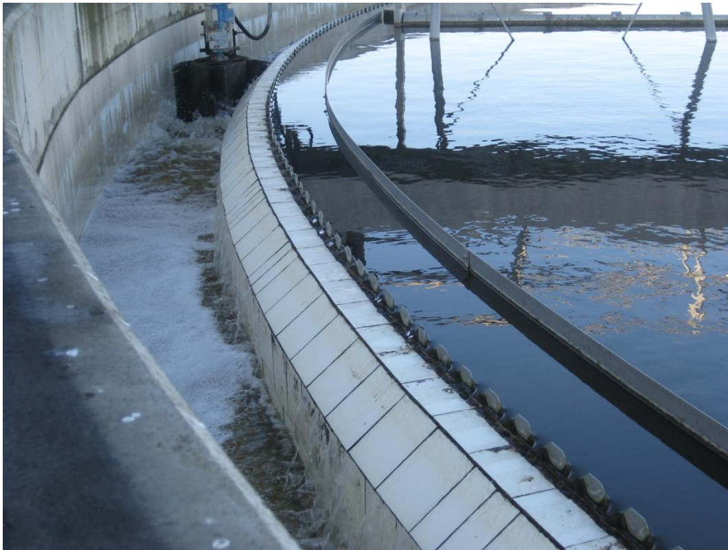
Figure 2.9 Dekantuesi Sekondar, Foto 3.8. b. e realizuar më Qershor 2012
