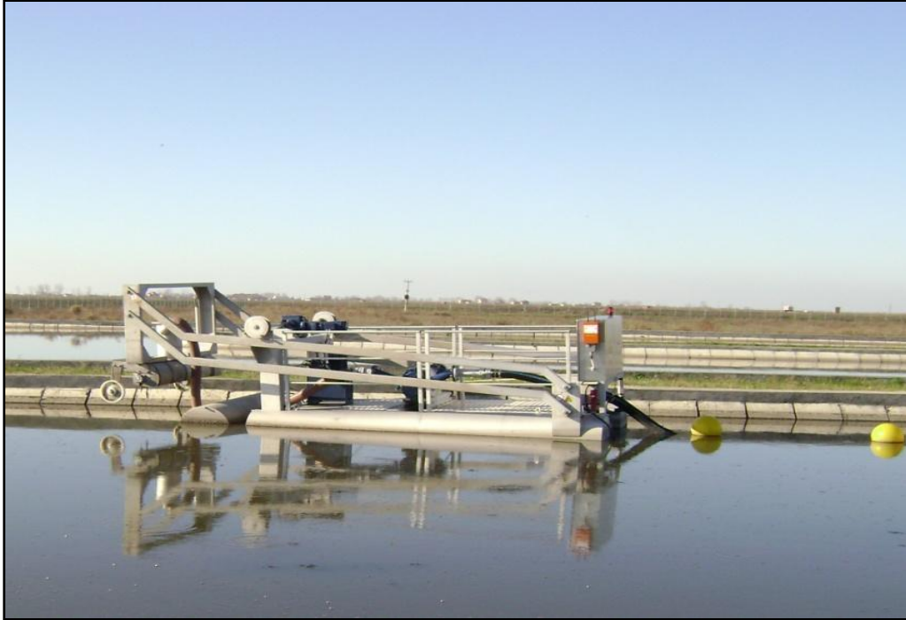
Figure 2.10 Makineria e largimit të llumit nga Pellgu Anaerobik në Impiantin e Kavajës
