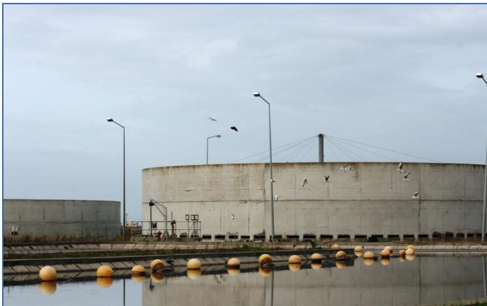
Figure 2.6 Filtri me Pikim (biofiltri) në njësine e trajtimit sekondar në Impiantin e Kavajës
