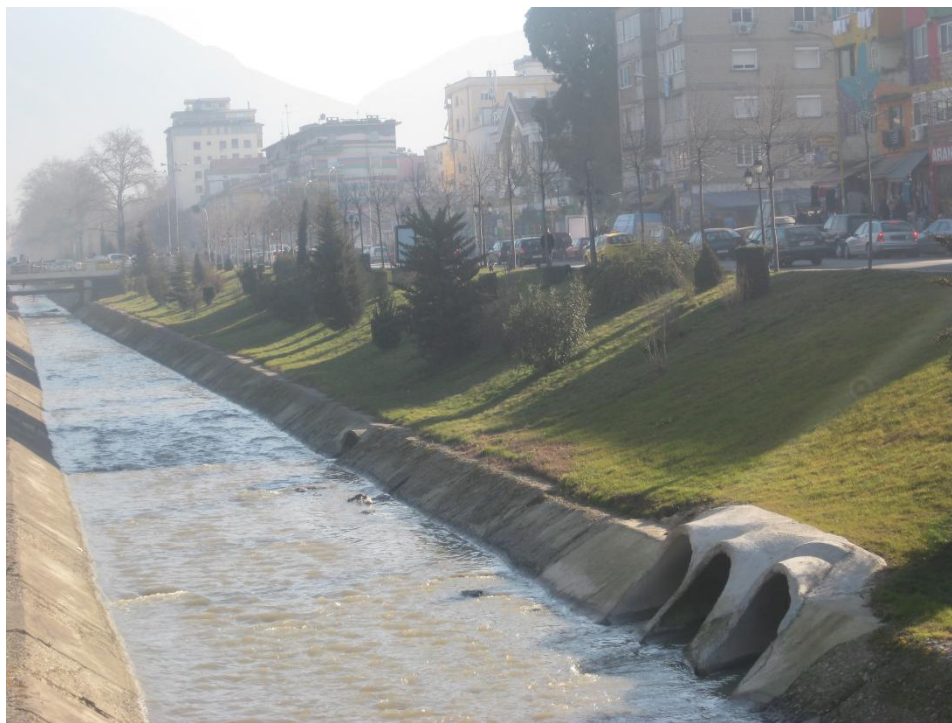
Figure 4.3 Tubacionet e shkarkimit të njësies Nr. 5, në Tiranë, në Lumin e Lanës
