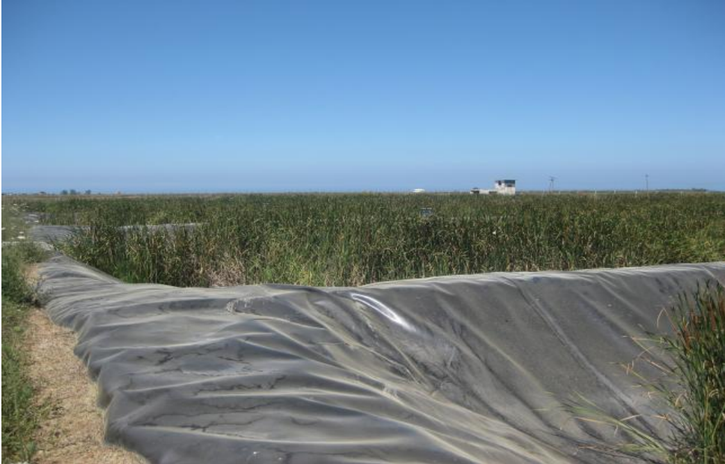
Figure 2.11:Foto 2.11. b Shtretërit e tharjes së llumit në Impiantin e Kavajës, në Nëntor 2011
