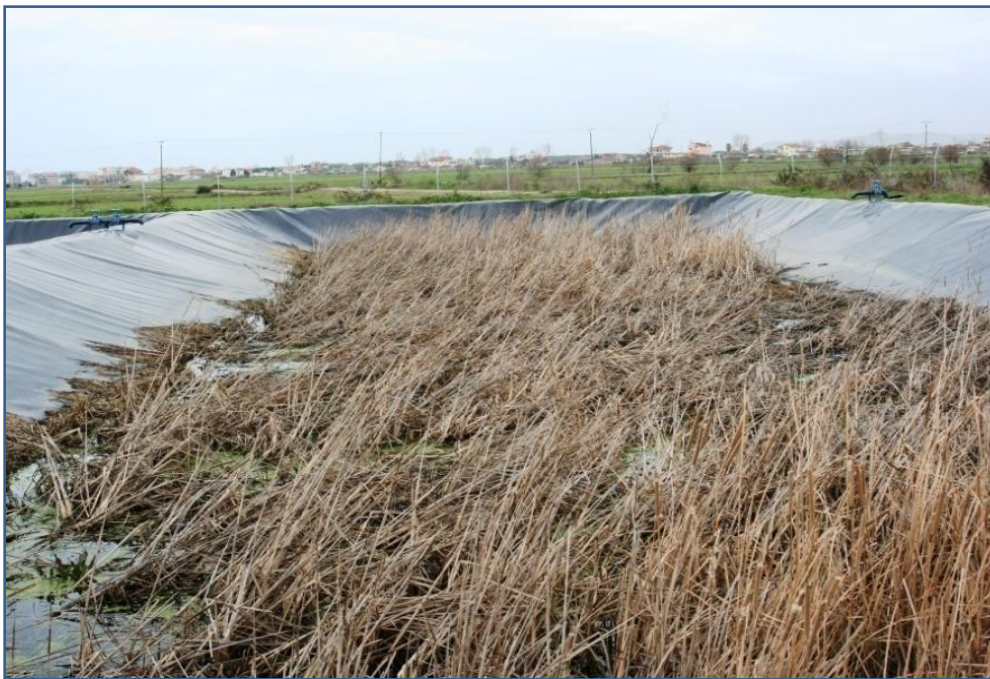
Figure 2.12 Shtretërit e tharjes së llumit nëImpiantin e Kavajës në Dhjetor 2010
