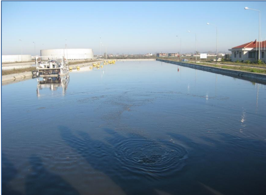
Figure 2.5 Pellgu Anaerob në njësinë e trajtimit primar të Impiantit të Kavajës
