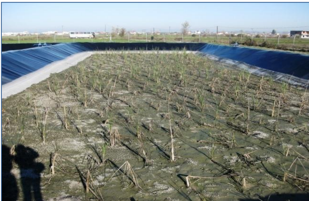
Foto 2.1. a Shtrati i tharjes së llumit në Impiantin e Kavajës. Foto e bërë në nëntor 2009
