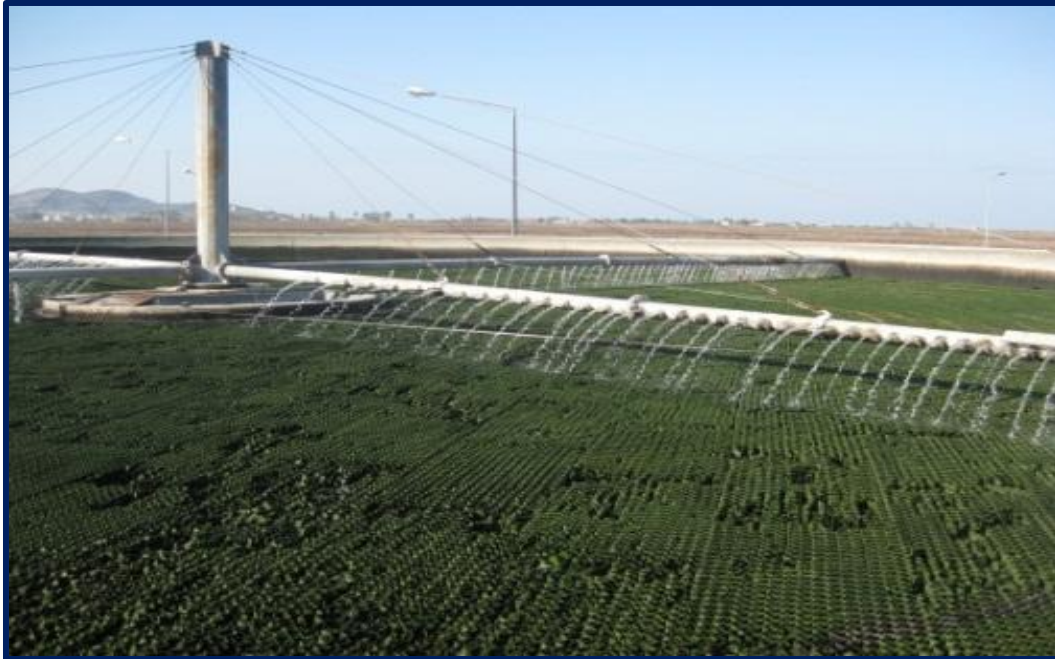
Figure 2.7 Foto e Filtrit me Pikim në Impiantin e Kavajës
