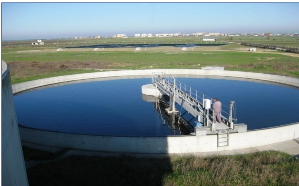
Foto 2.9.a Dekantuesi Sekondar në Impiantin e Kavajës, foto e bërë më Shkurt 2009
