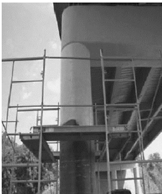
Figura 4.10 Kolona gjatë përforcimit
