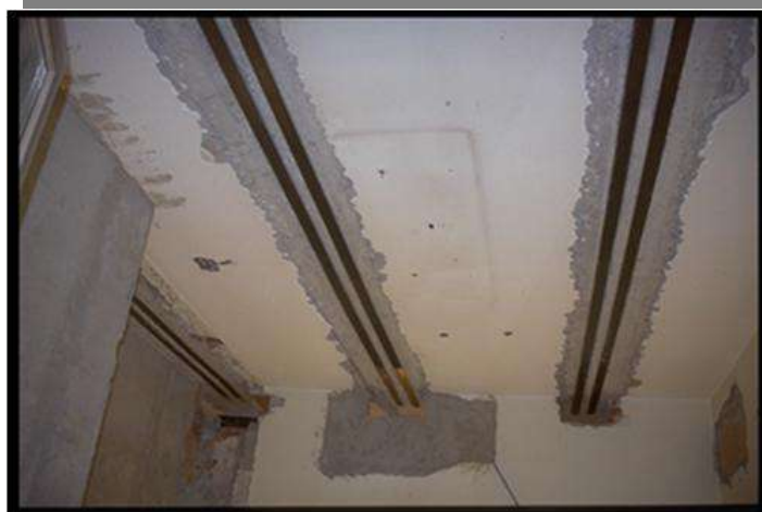
Figura 2.7 Soleta e përforcuar me FRP
