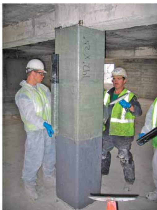
Figura 4.8 Përforcimi me FRP i kolonave
