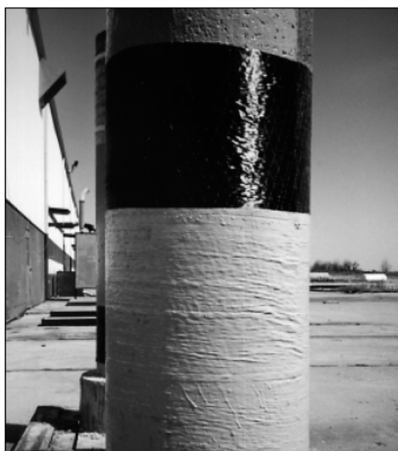
Figura 3.34 Aplikime të përforcimit të kolonave me FRP
