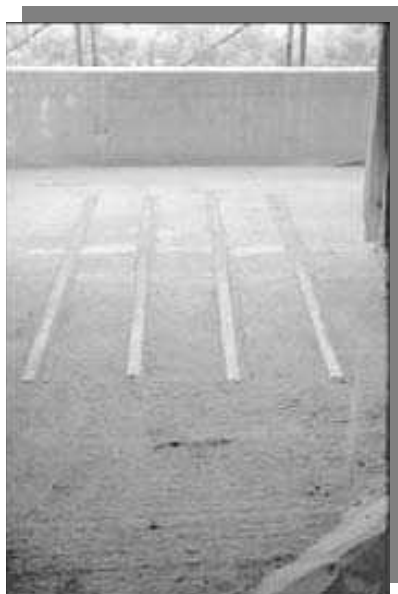
Figura 2.8 Soleta konsol e përforcuar me FRP
