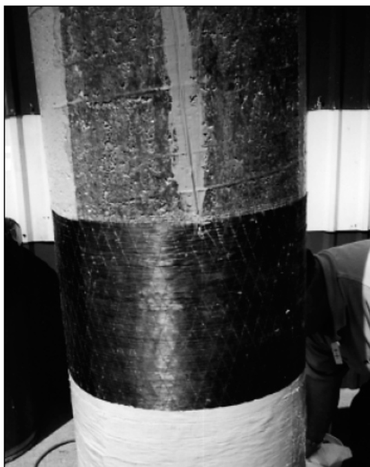
Figura 3.33 Aplikime të përforcimit të kolonave me FRP
