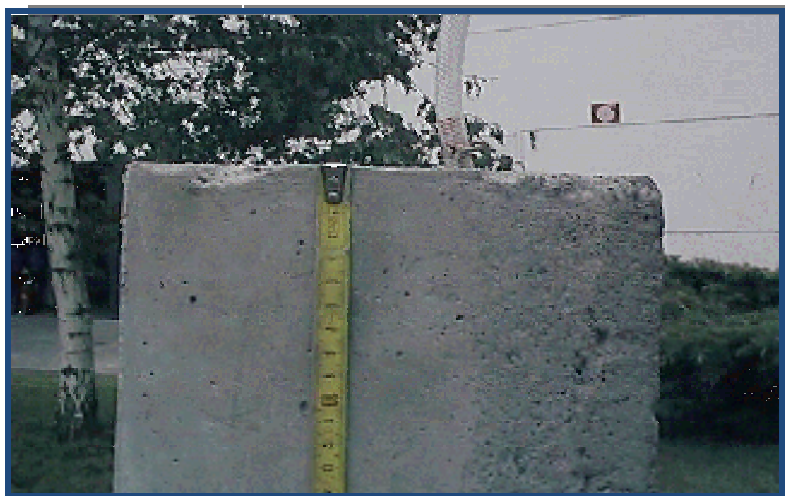
Figura 2.10 Gjendja e sipërfaqes para vendosjes së FRP
