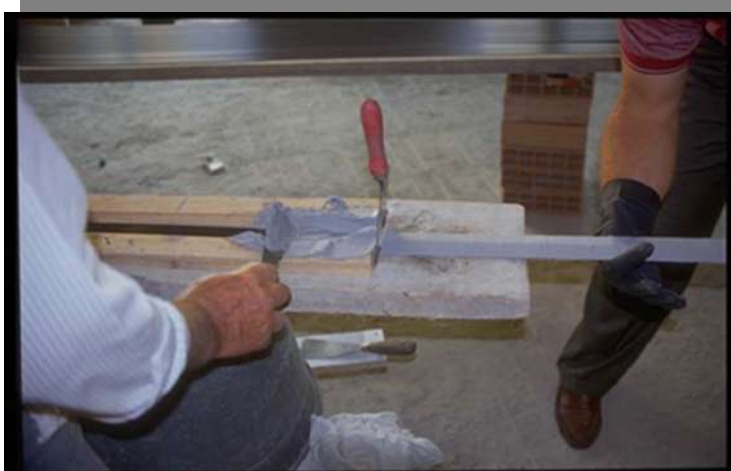
Figura 2.5 Përgatitja e FRP në kantier
