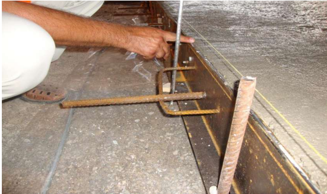
Foto 1 Fuga kontolli, ndërtimi me kunja pas betonimit të një krahu
