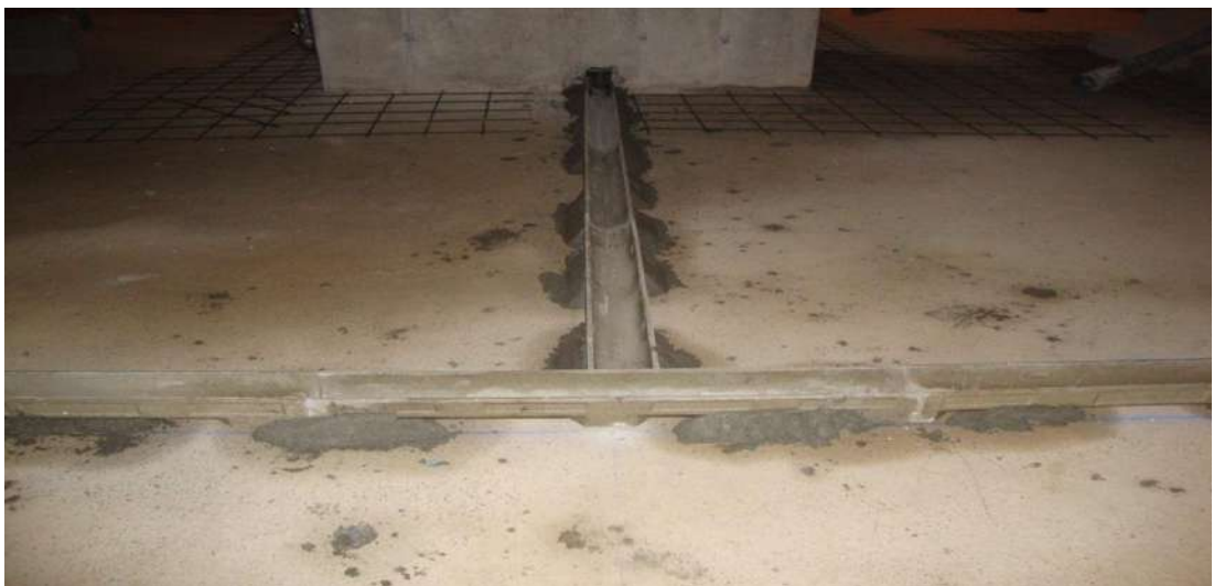
Foto 6 Grumbullimi i ujit me anë të kanalina
