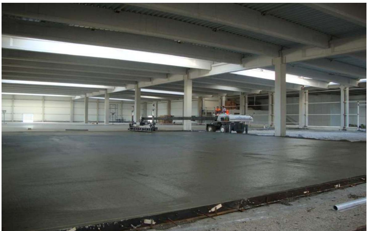
Foto 4 Betonimi i dyshemesë dhe nivelimi me makinë vetëniveluese
