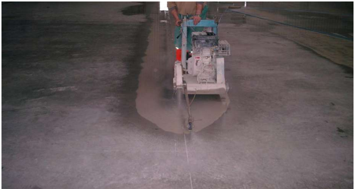
Foto 8 Prerja e dyshemesë me makineri.
