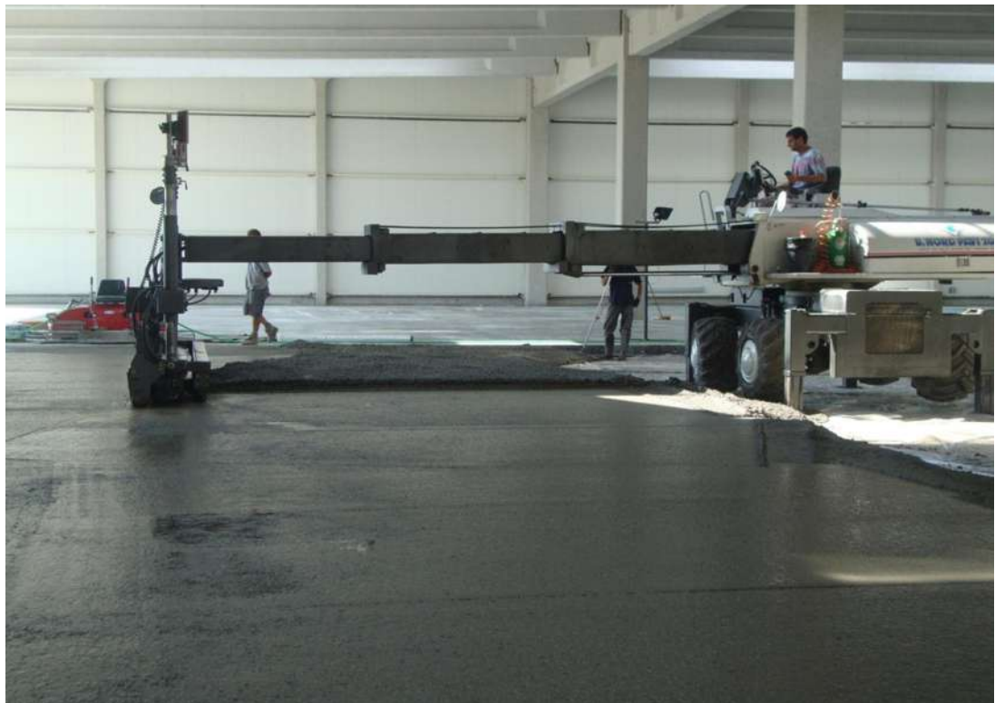
Foto 2 Betonimi i dyshemesë dhe nivelimi me makinë vetëniveluese
