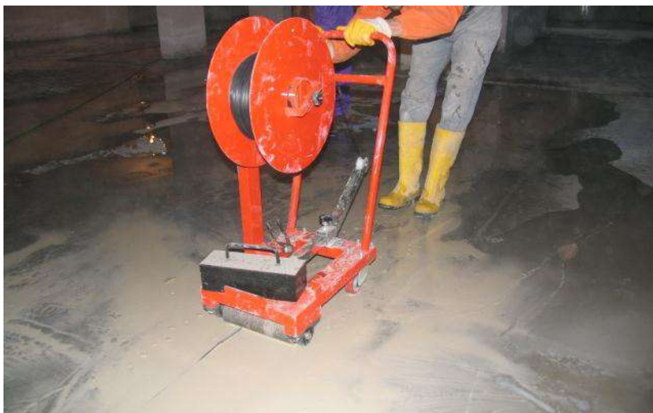
Foto 8 Mbyllja e fugave me profile PVC
