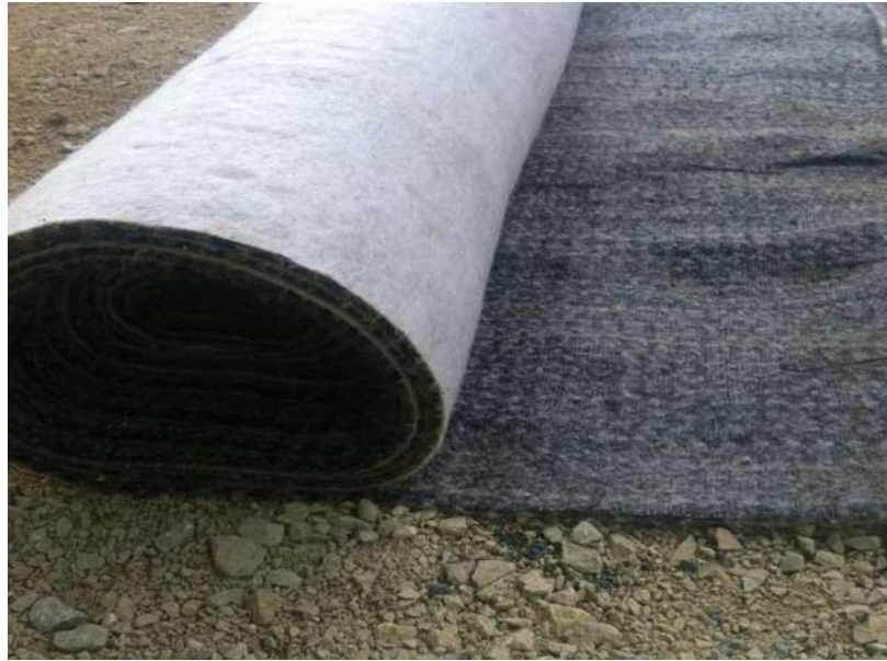
Foto 3 Vendosja e shtresës ndarëse dhe hidroizolues (material sintetik)
