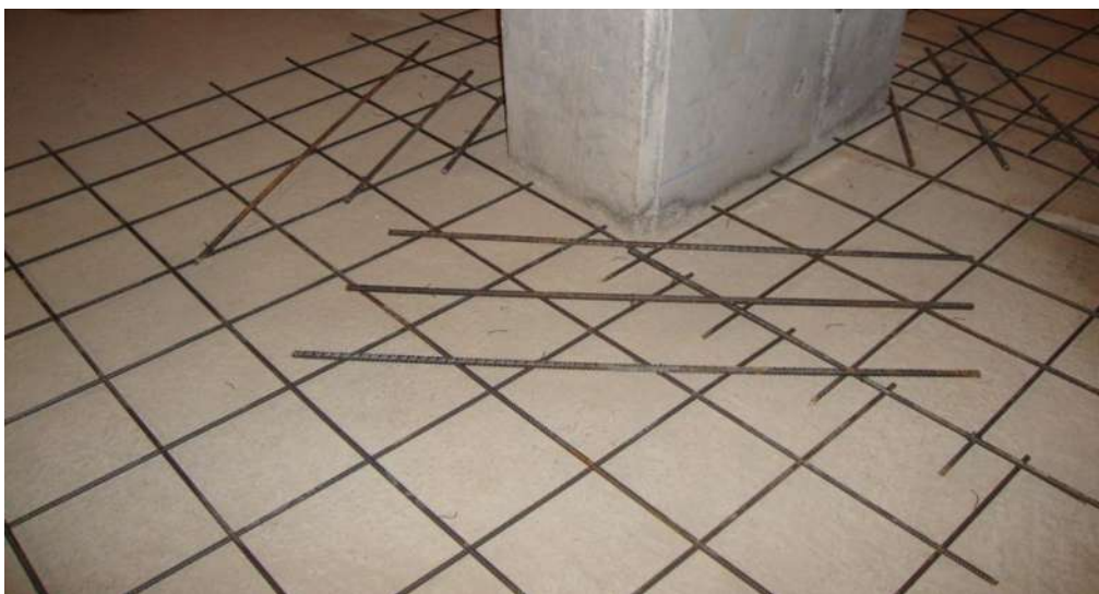
Foto 4 Armatura shtesë në afërsi të kolonës
