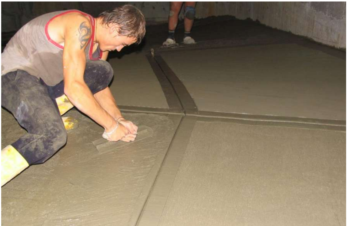
Foto 10 Realizimi i shtresës përfundimtare kundër fërkimit
