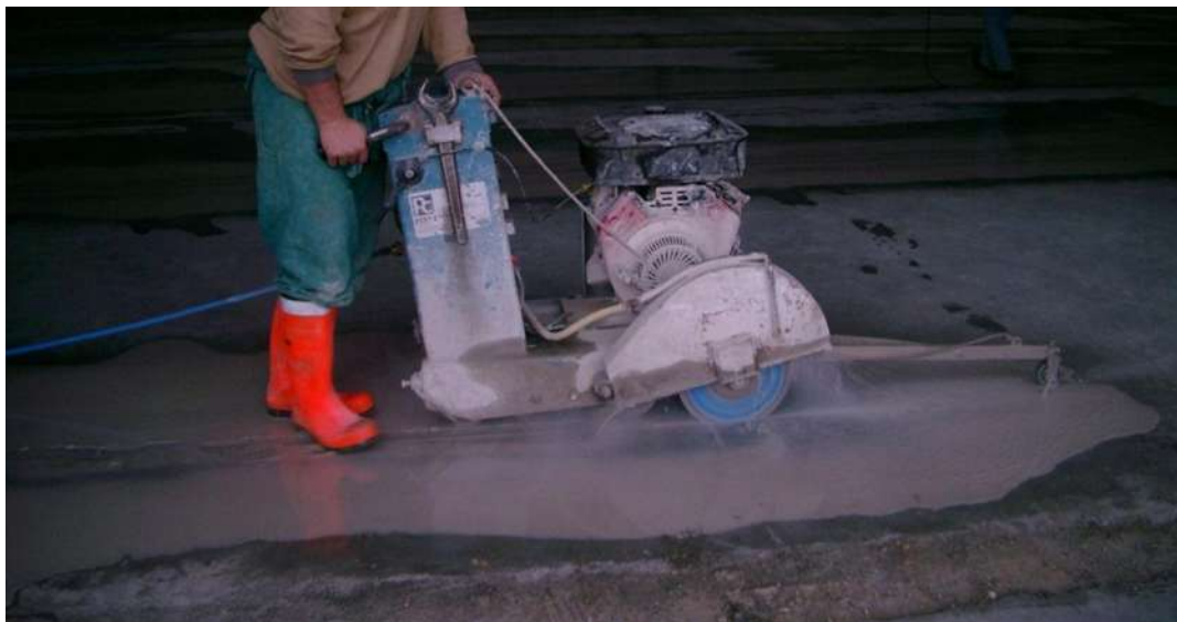
Foto 7 Prerja e dyshemesë me makineri
