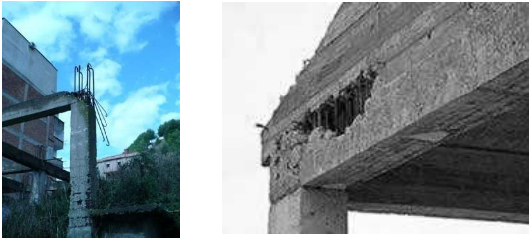
Figura 1.2.1.2, 1.2.1.3: Fenomeni i segregimit të betonit dhe mosngjeshjes referuar standardit
