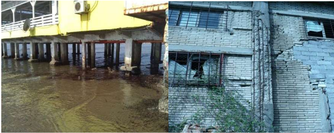
Figura 1.1.7: Pista në Hekurudha, Durrës Figura 1.1.8: Ish Godinë në ndërmarrjen e Plastikës 1928, e rikonstruktuar në vitet 1960 Shkozet, ndërtuar në 1965, Durrës
