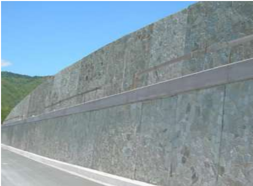
Foto 3.1 (c) panele prej betoni
