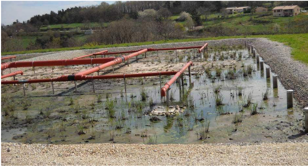
Figura 57. Fillimi i Bllokimit të efluentit – në këtë rast duhet të intervenohet menjëherë me riparimet e nevojshme
