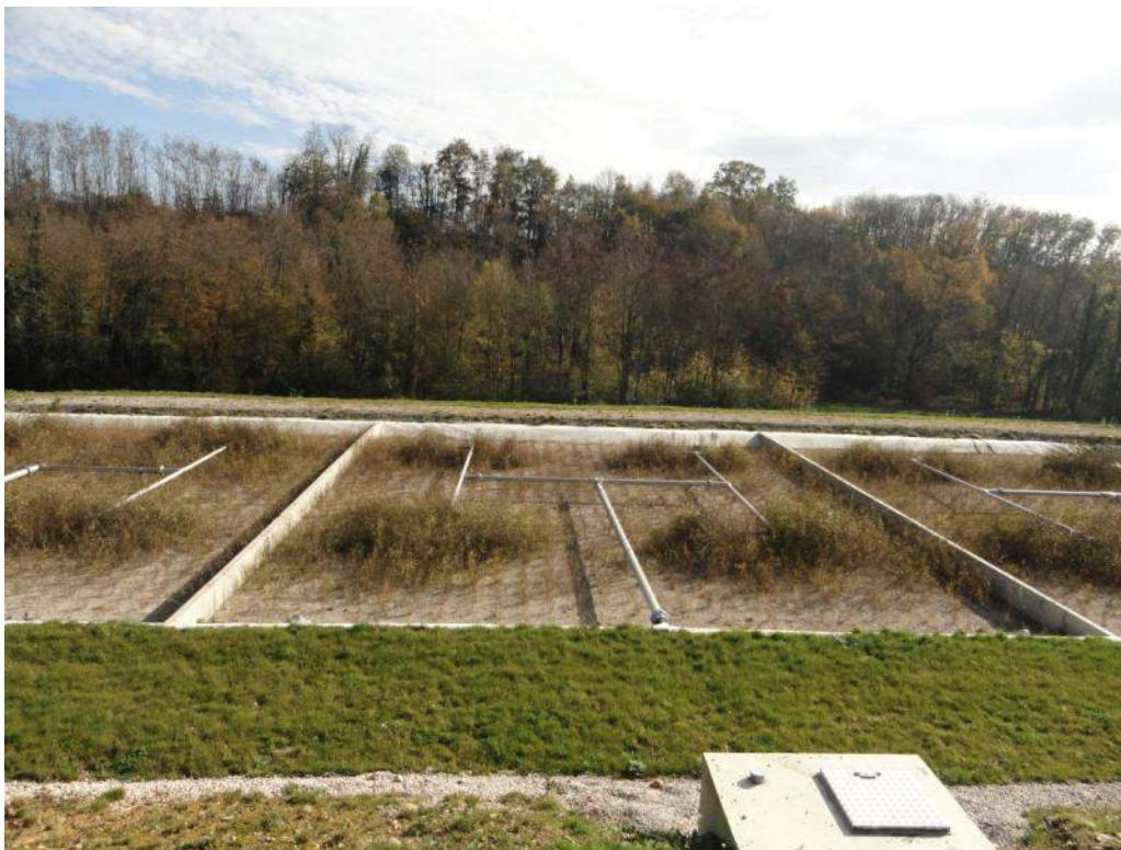
Figura 62. Pondet vertikale të mbjellura me kallamishte të reja, Francë 2011
