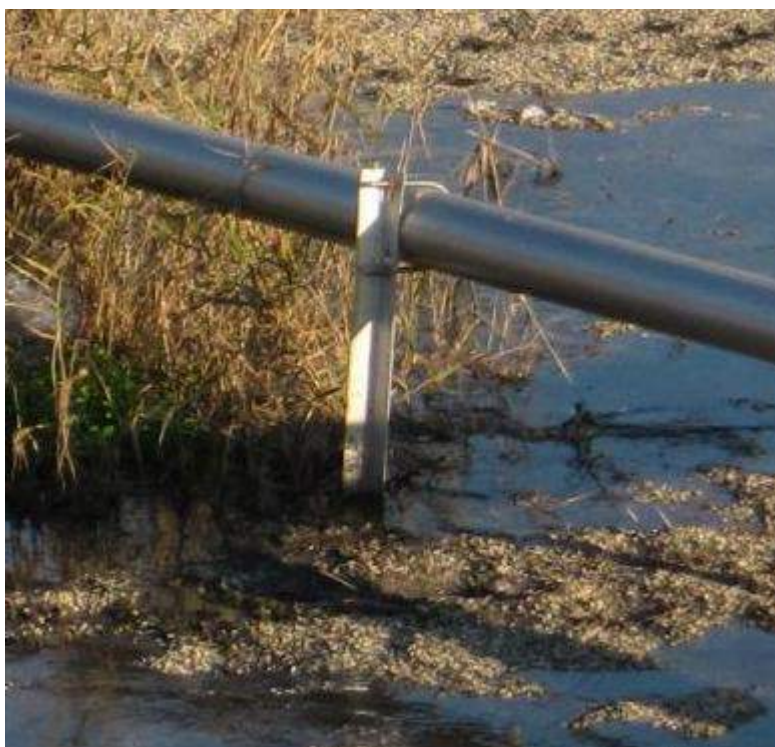
Mbajtësit metalik të gypave shpërndarës – mundësojnë rregullimin e pjerrtësisë së gypit
