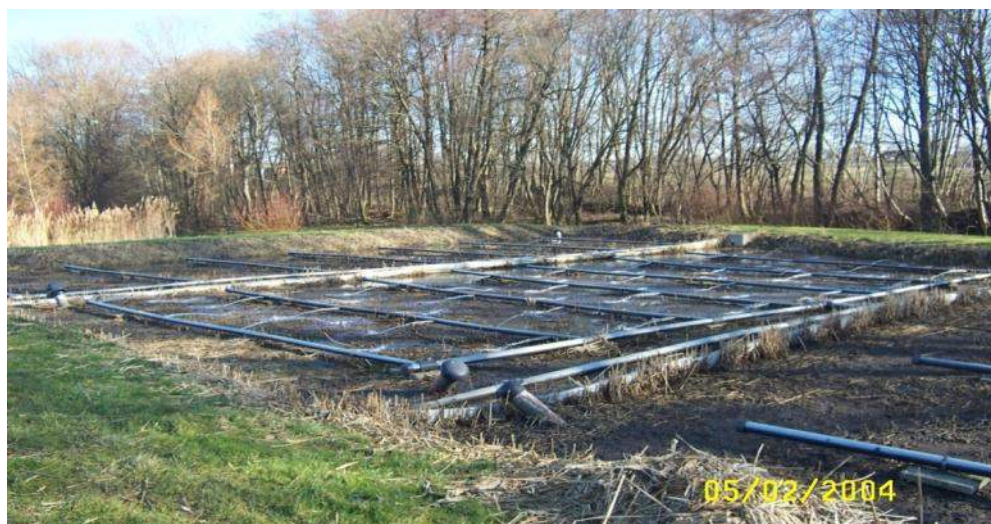
Figura 64. Etapa e 2-të e pondeve vertikale, Francë, dimër 2004
