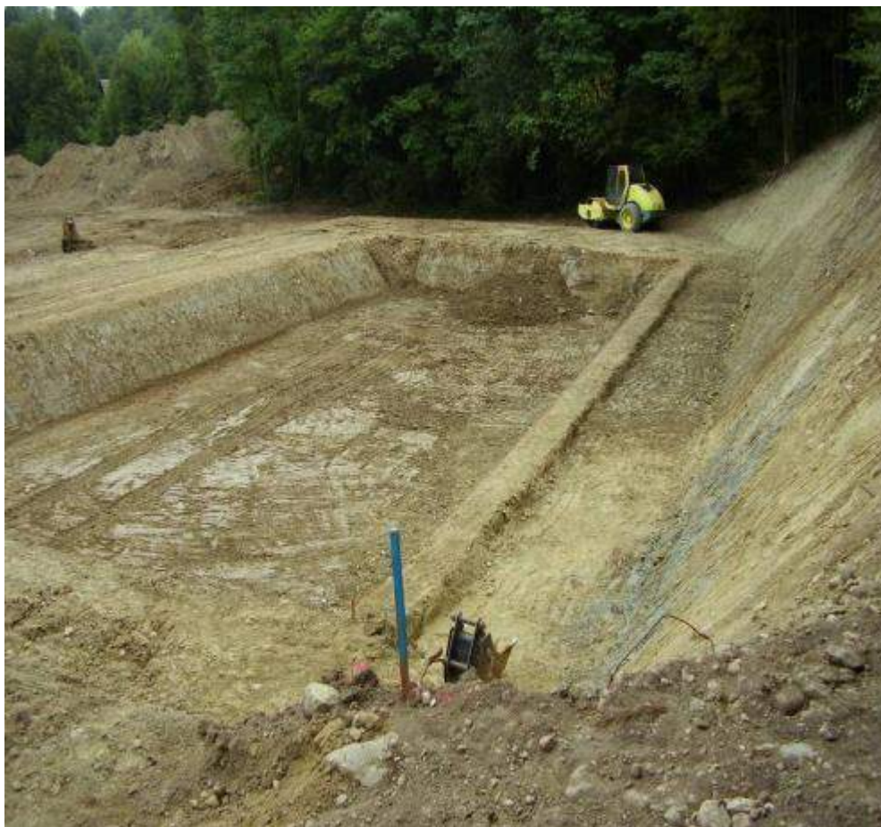
Platforma e ndërtuar me gërmim dhe mbushje të terrenit: rrugët, fundi i filtrit me pjerrtësi, vendi për ankerimin e membranës etj.
