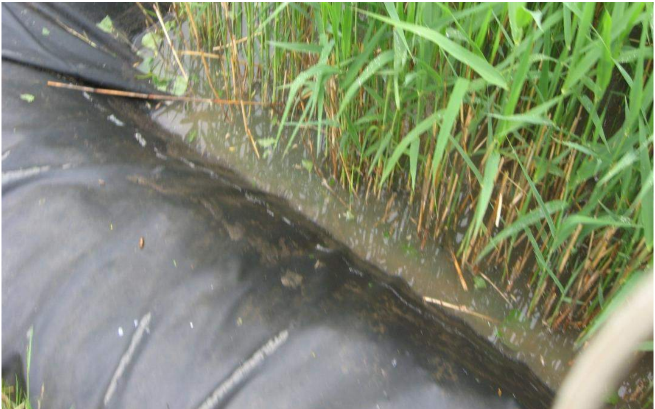
Figura 56. Bllokimi – ujërat e zeza nuk infiltrohen në shtrat, por mbesin në pjesën e sipërme
