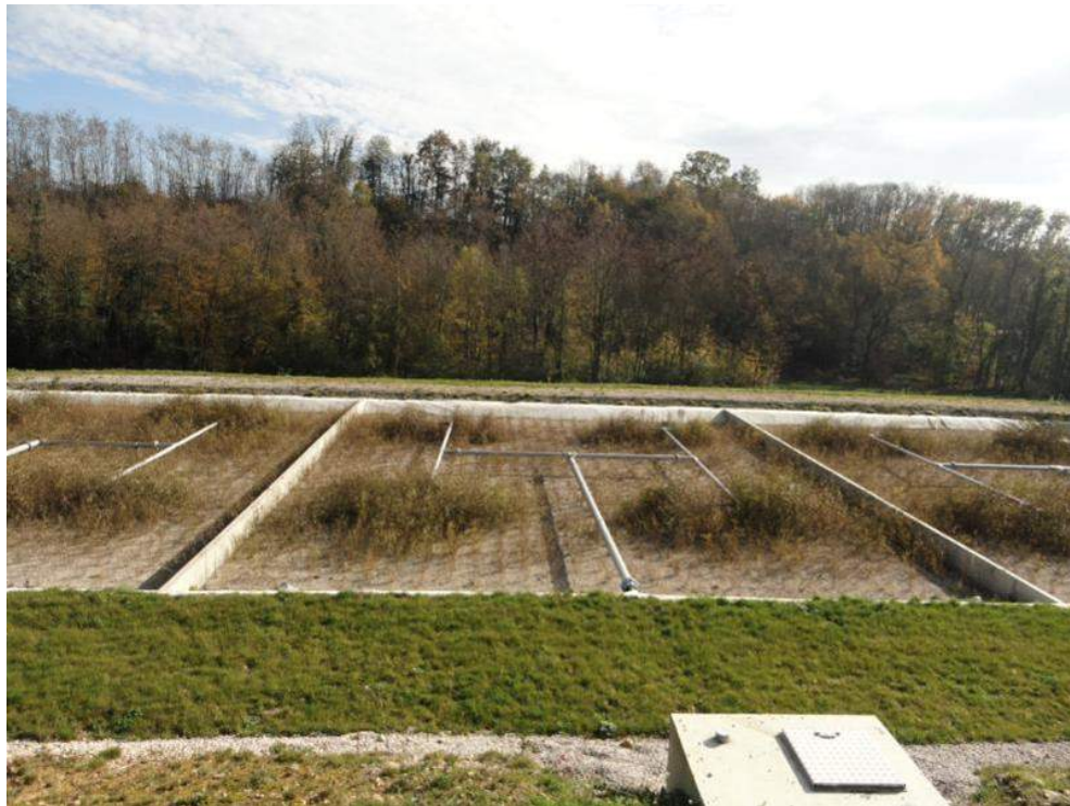
Figura 25&26. Pondi Artificiale Horizontal.
