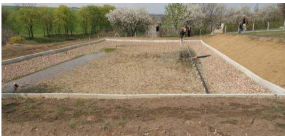
Pondet e ndërtuara me rrjedhje horizontale me kallamishte, Moldavi, 2010
