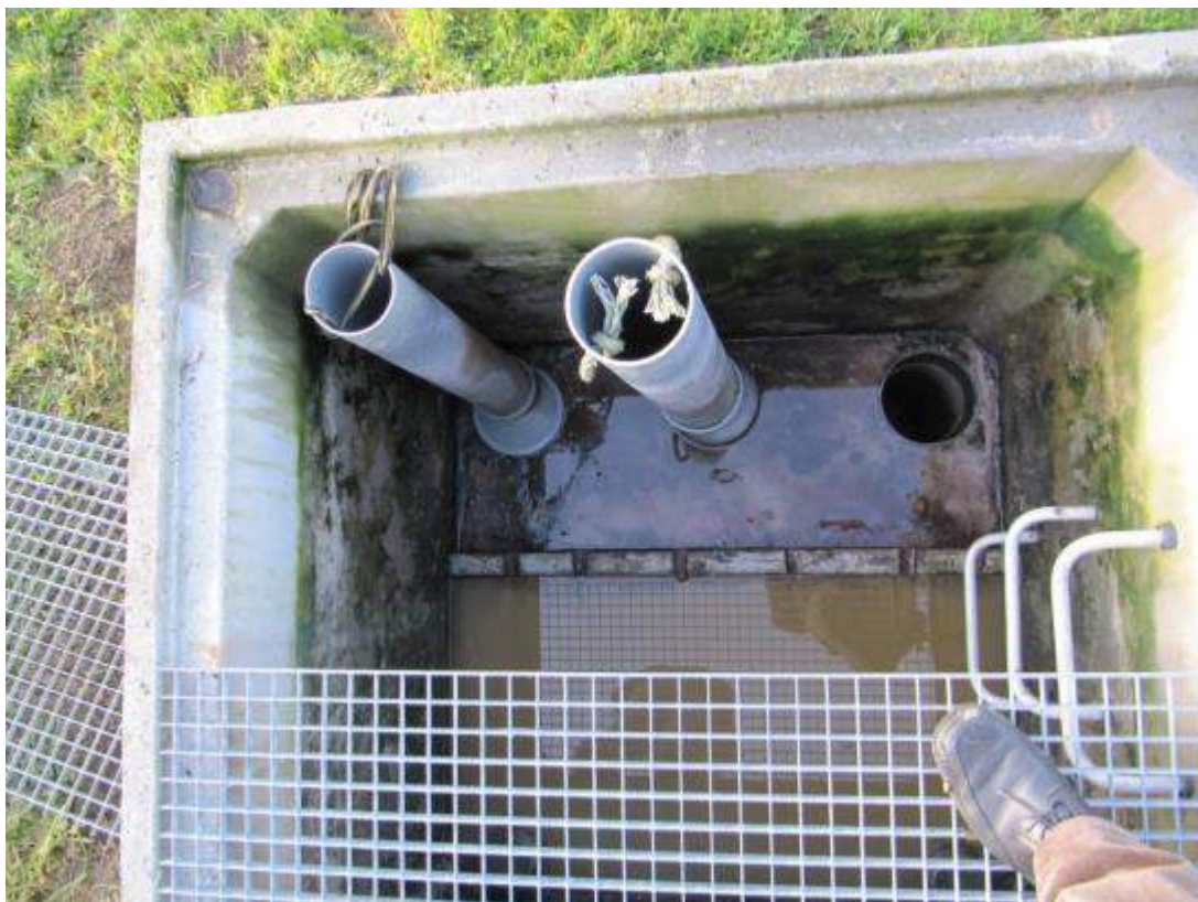
Hapësira shpërndarëse në Njësinë e Parë Shtytëse. Gypi dalës “femëror” mbyllet me gyp “mashkullor” të të njëjtit diametër.
