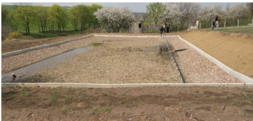
Figura 66. Pondet e ndërtuara me rrjedhje horizontale me kallamishte, Moldavi, 2010
