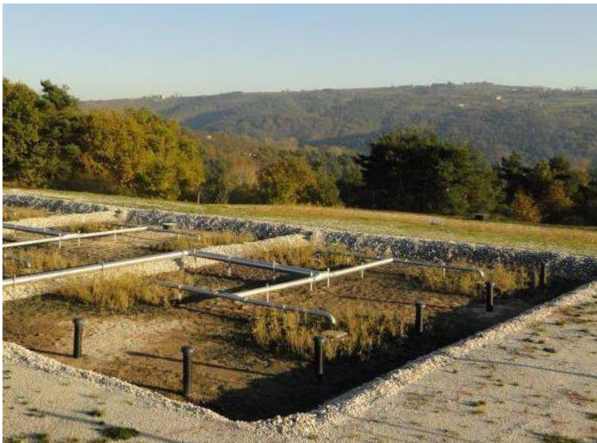
Pamja e përgjithshme e etapës së parë: ndarëset në mes filtrave, oxhakët me “kapelë”, gypat shpërndarës bashkë me mbajtëset metalike, pikat shpërndarëse, mbjellja me kallamishte etj.
