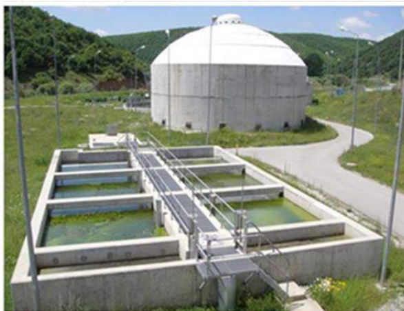
Figura 14. WWTP ne Skenderaj – Kosovë
