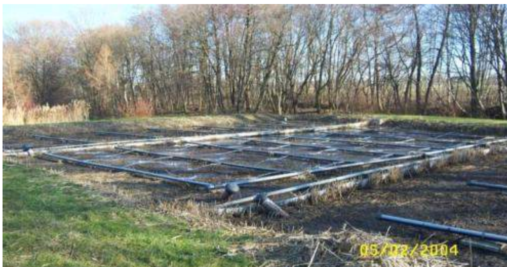
Etapa e 2-të e pondeve vertikale, Francë, dimër 2004 (foto Cemagref)
