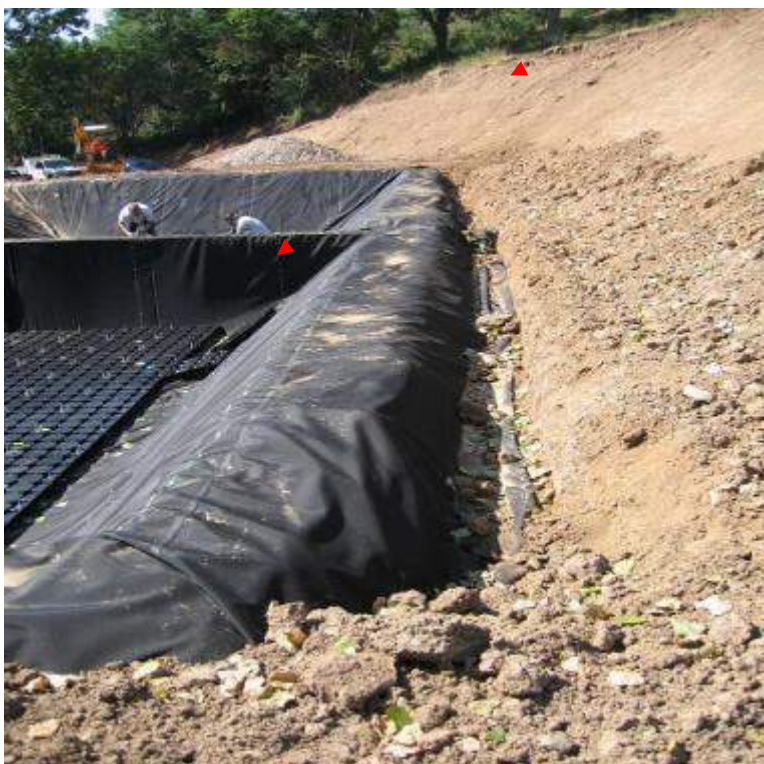
Ankerimi i membranës dhe kanali evakuues
