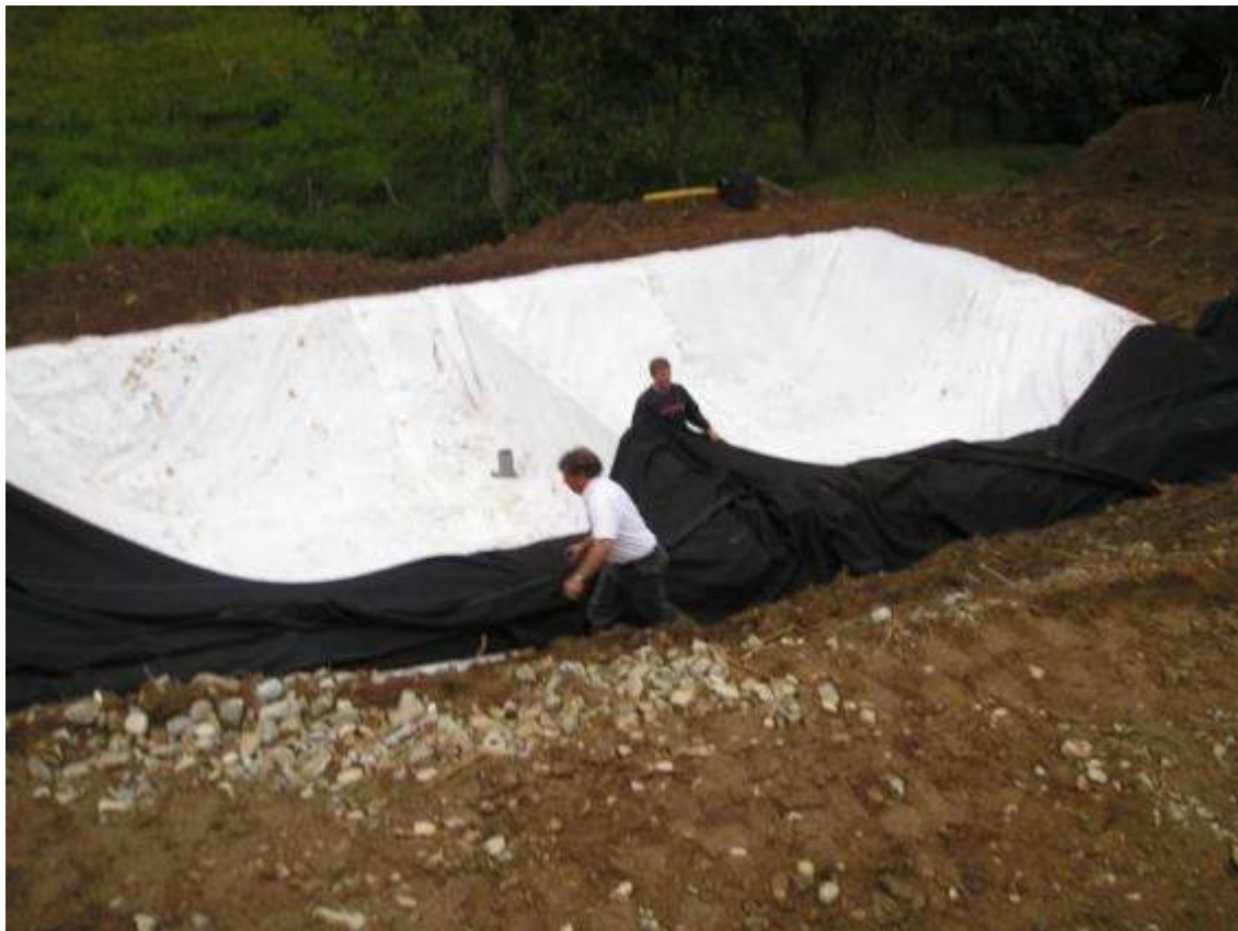
Membrana shtrohet mbi gjeotekstil
