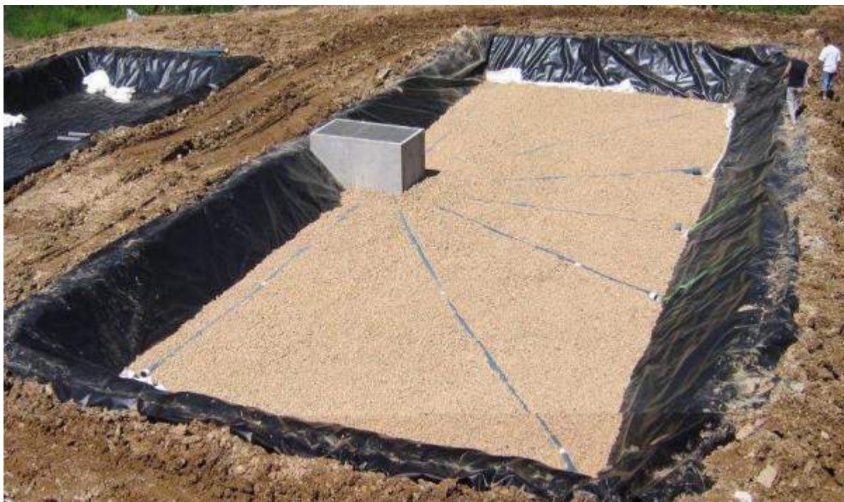
Etapa e parë- sistemi i drenazhimit dhe puseta mbledhëse e saj.
