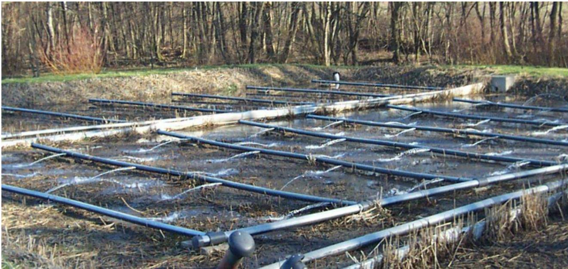
Figura 43. Pondi artificiale fusha Horizontale.
