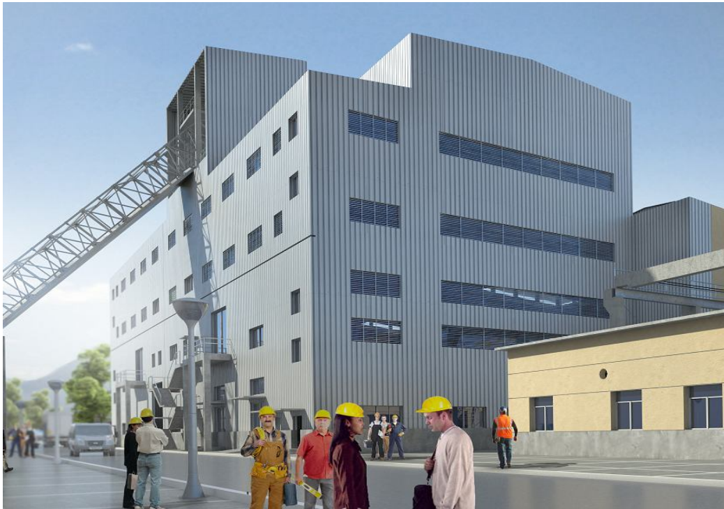
Fig.6.2. Uzina e Ferrokromit, Elbasan. Reparti i shkrirrjes.
