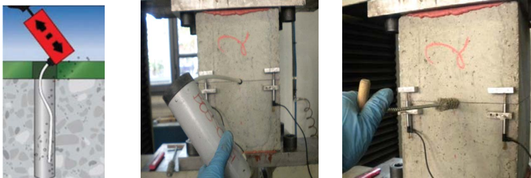
Figura 16: Pastrimi i vrimës së instalimit.
