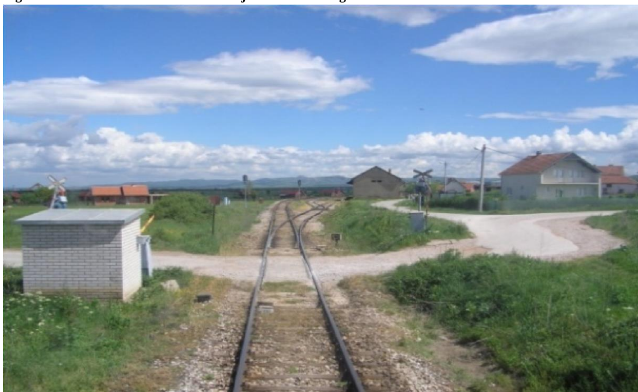
Figura 23: Kalimi në nivel centralizues me gjysëmpengesë në zonën e stacionit
