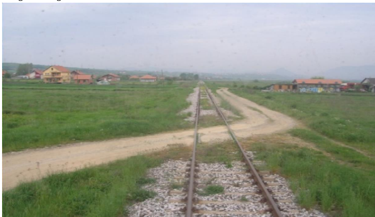
Figura21: Shembull i pasigurt i nivelit në kalim(rrugë)
