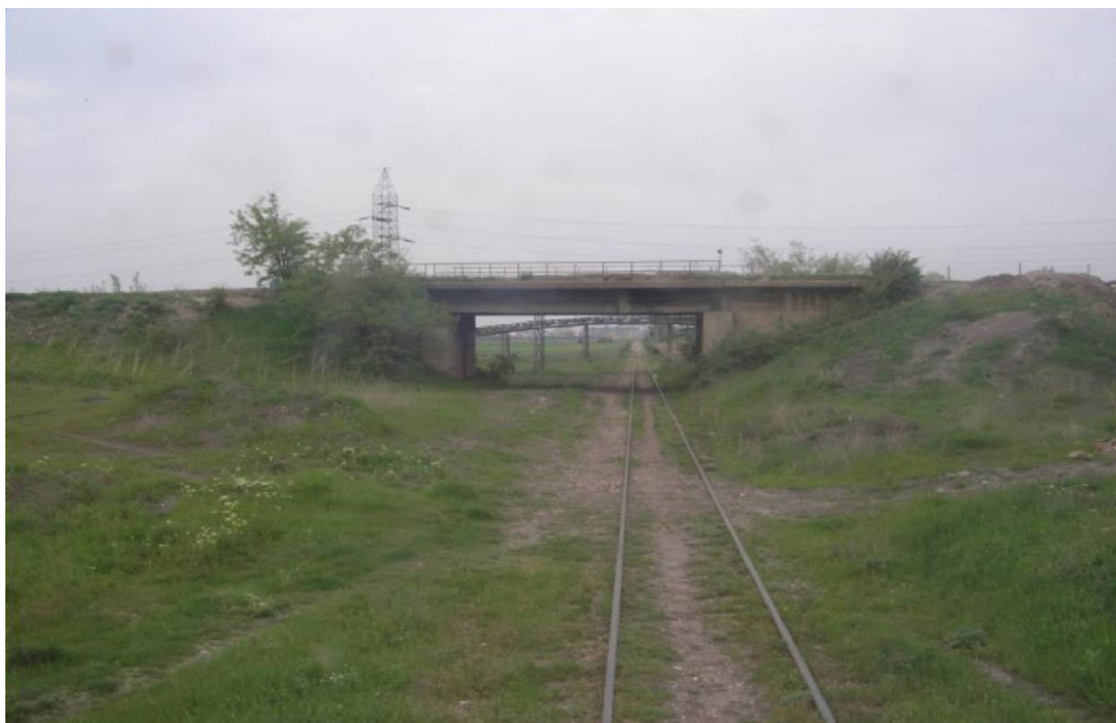
Figura7: Kushtet e binarit pa balast dhe kanale
