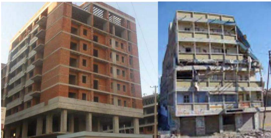
Figura 5. 6: a) Objekt në Tiranë me kat përdhe të dobët, b) Objekt në Indi Kat i dobët në mes
