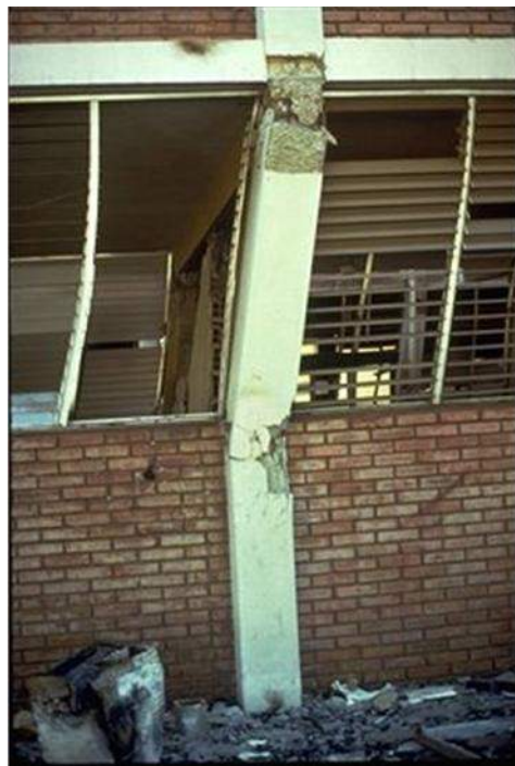
Figura 2. 2: Dëmtimi i godinës si rezultat i kollonave të shkurtra
