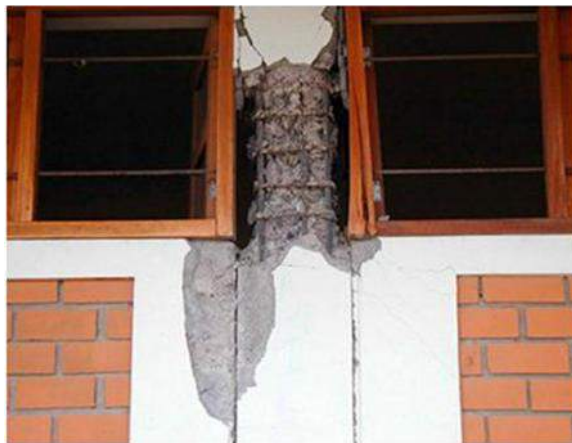
Figura 5. 9: Shkatërrim i kullonës si pasojë e bllokimit nga muratura
