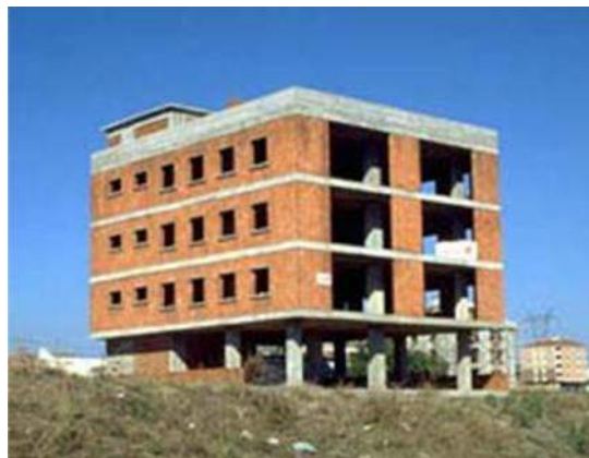
Figura I: Strukturë tip ramë me trarë të sheshtë
