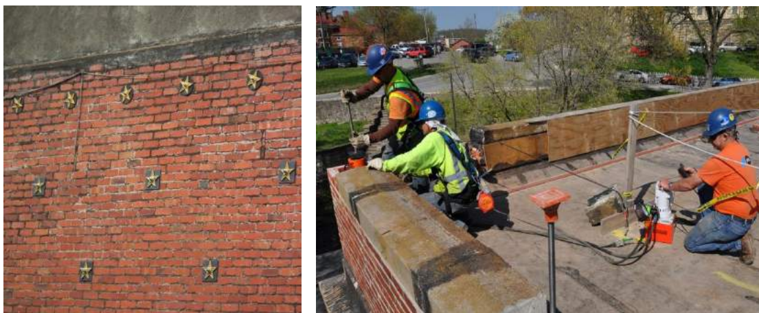
Fig. 2. 13 Elemente- ankera special për përforcimin e murit dhe paranderja vertikale e një murit
