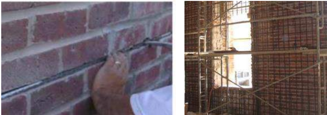
Fig. 2. 12 Përforcimi i fugës së murit me armatur dhe llaç dhe përforcimi i murit me rrjeta të armaturës
