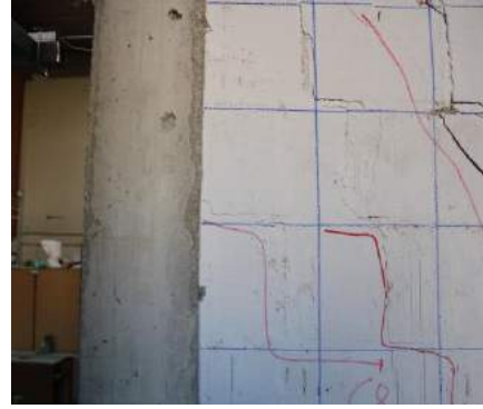
Fig. 5.4.59 Foto nga ekzaminimi i R BA 5 gjendja e plasarit tek muri diagonale – përgjat fugave vertikale dhe horizontale-
