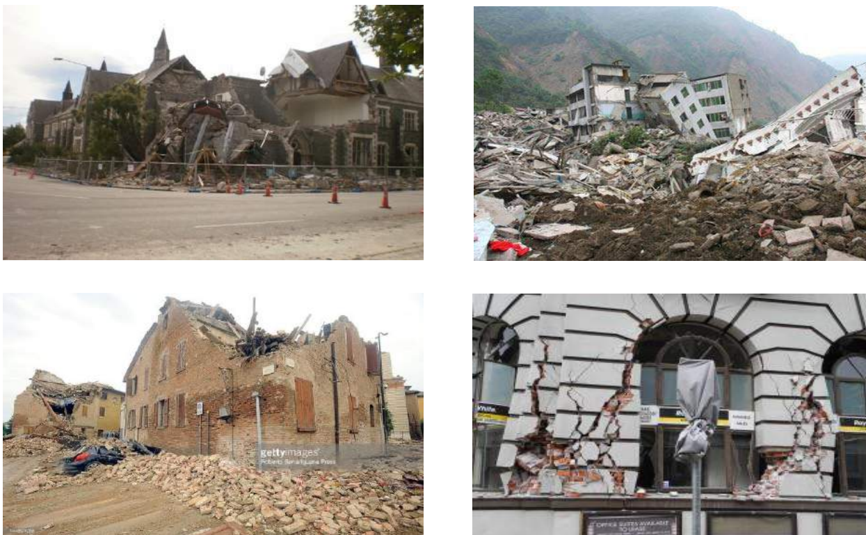
Fig. 1.8 Disa raste dëmtimesh dhe shkaterrime të strukturave me muraturë
