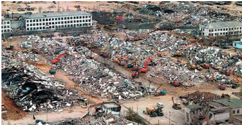
Fig. 1.7 Kompleksi i tërë banesash me mure mbajtëse transversale i shkatërruar nga tërmeti i Neftegorski Rusi 1995
