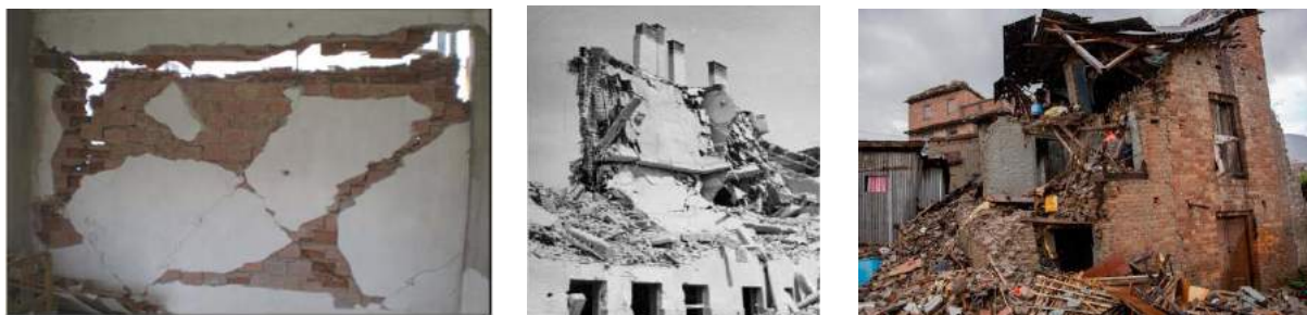
Fig. 1.9 Disa dëmtime dhe kolapse nga trevat tona
