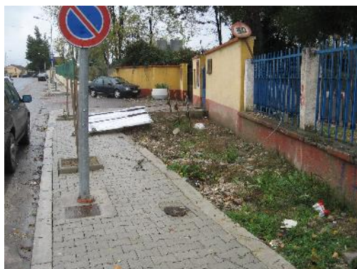
Gjendja ekzistuese, muri rrethues
