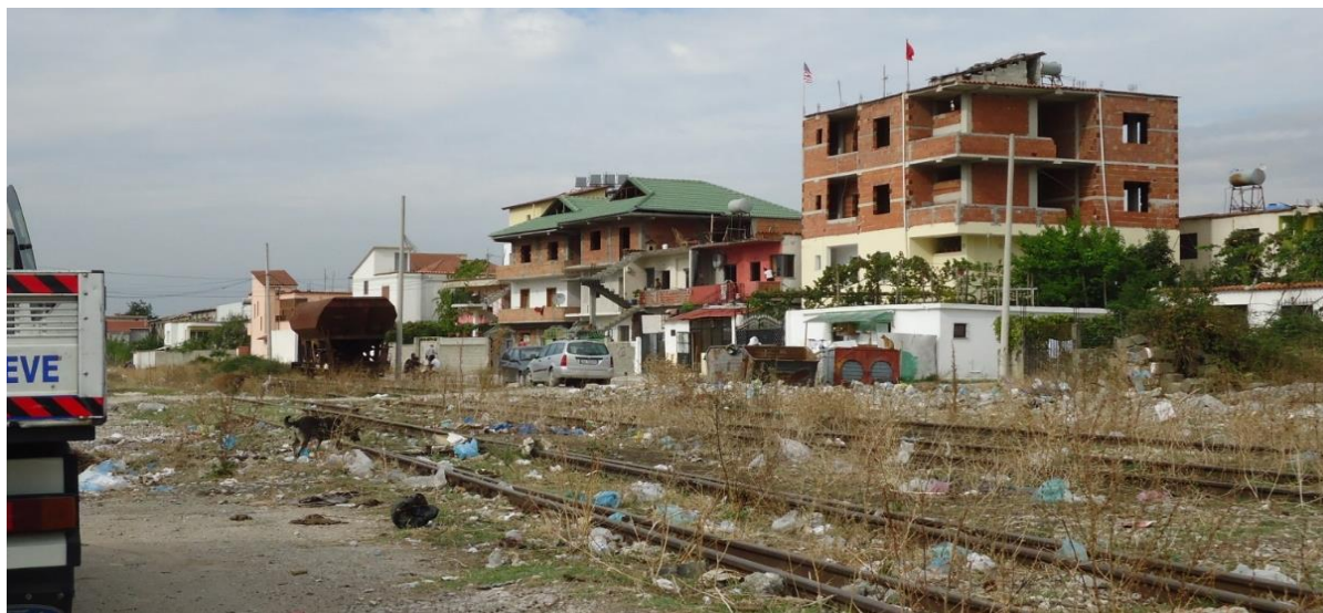
Figura 29: Gjendja ekzistuese e zonës në studim, rrjeti hekurudhor
