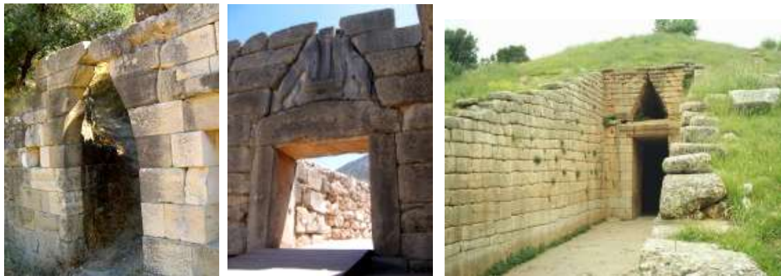
Figure 18. Hyrja në Temenos, porta e luanit në Mikenë, hyrja në varrin e Agamemnonit përdorin hark të rremë që shkarkon vetëm vertikalisht në bazë të parimit të spostimit gradual të gurëve në formë trekëndëshi.
