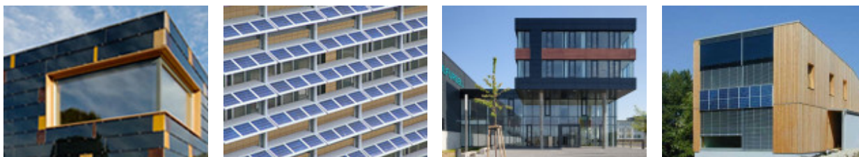
Fig. 5.20: Shembuj instalimesh të moduleve PV në fasadë
