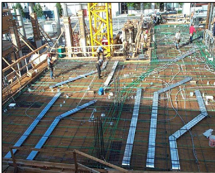
Figura 3.49 Realizimi i soletave PT në objekt [25]
