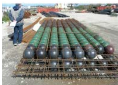
Figura 3.16 Realizimi ne objekt i soletave cobiax
