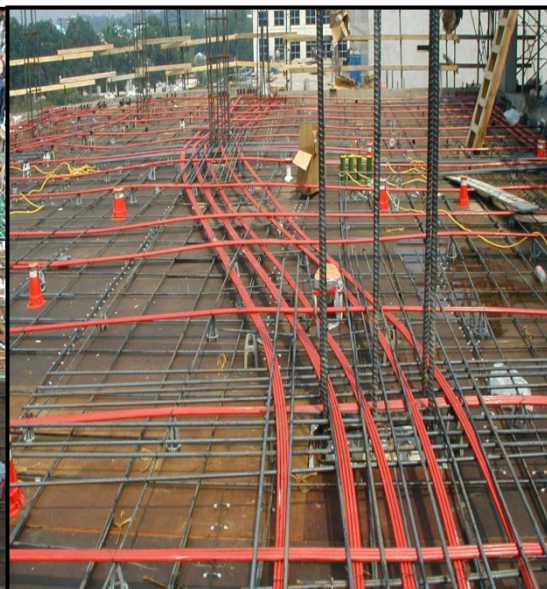
Figura 3.49 Realizimi i soletave PT në objekt [25]
