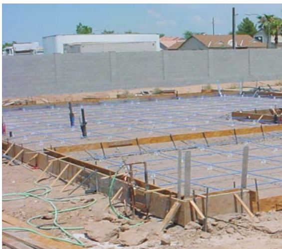
Figura 6.7 Përdorimi i teknologjisë së post- tensionimit
