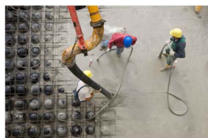
Figura 3.16 Realizimi ne objekt i soletave cobiax
