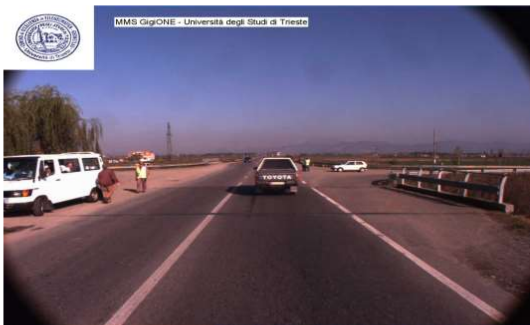
Fig 5.6. (foto 3287 projekti”SISA”) km 35 km 837 m është ndërtuar kryqëzim në disnivel në Patok – Laç
