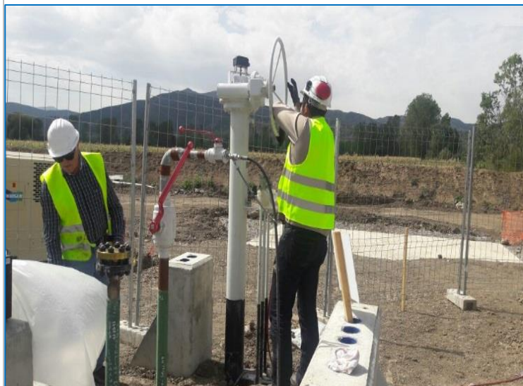
Fig.5.23,Mbaroj koha e mbajtjes nën presion, diferenca e presionit është brenda kushtit të pranueshmërisë.Mbyllet valvulen 16” për të përformuar testin në hermeticitet.
