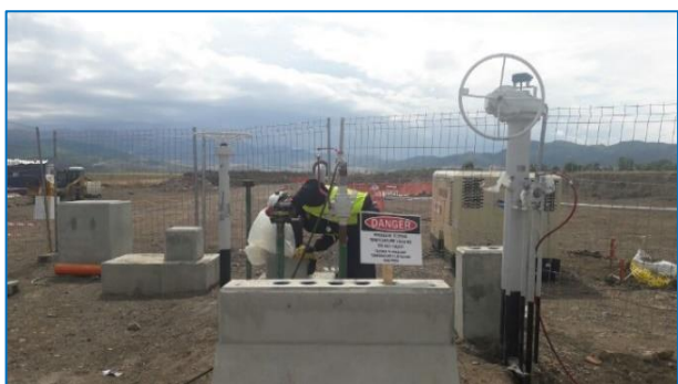
Fig. 5.15, Kontroll vizual në të gjitha seksionet e ekspozuara. (Filluam presimin deri në 100 të presionit të testimit).
