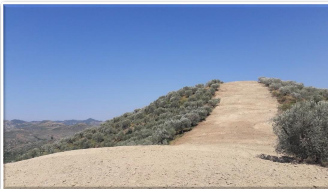
Fig.2.26, Mbulimi i tubit dhe kthimi i tokës në gjendjen fillestare
