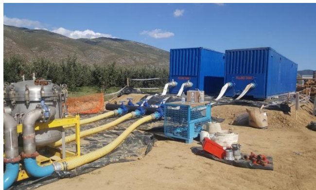
Fig.6.12, Uji filtrohet dhe më pas dërgohet në depozitat e ujit
