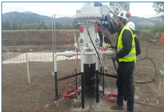
Fig. 5.13, Kontrolluam seksionin për rrjedhje në të gjithë komponentet e ekspozuar
