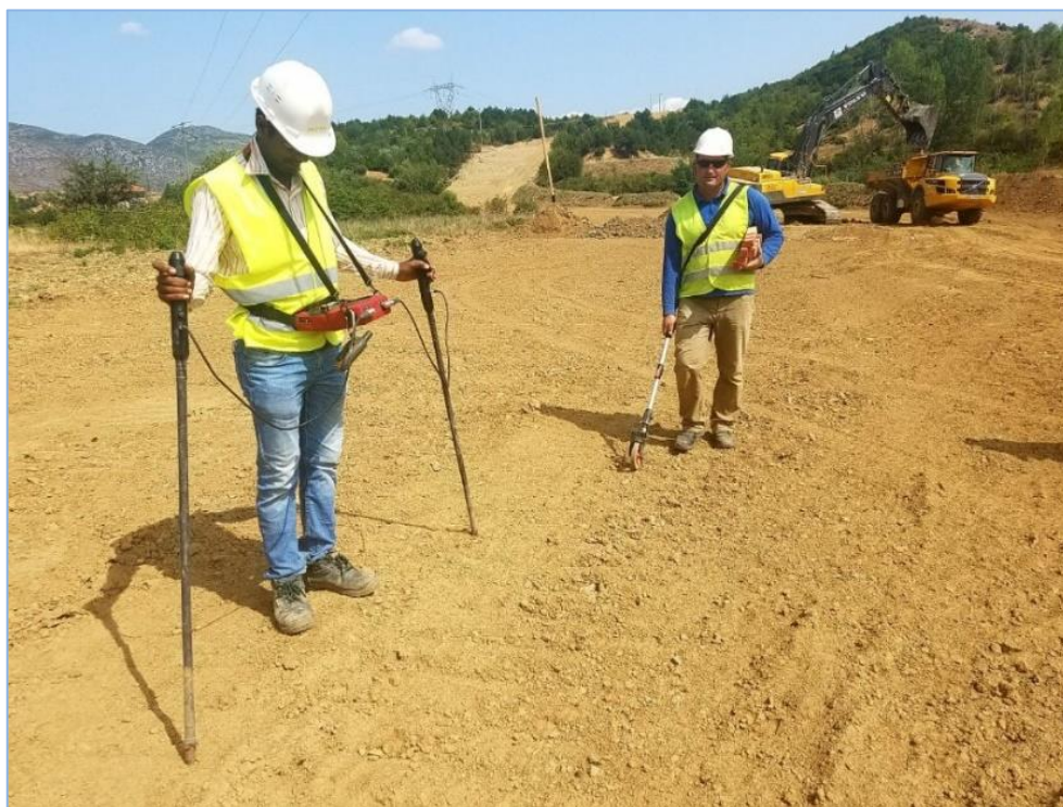
Fig.3.12, Operatori i DCVG gjatë një analize DCVG në pikën kilometrike 22 të tubacionit TAP.
