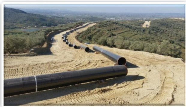
Fig 2.4 Faza pas përfundimit të hapjes së tubove
