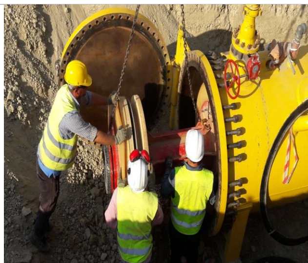
Fig 4.17 ,Futja e Pigut me pllakën e aluminit në seksion
