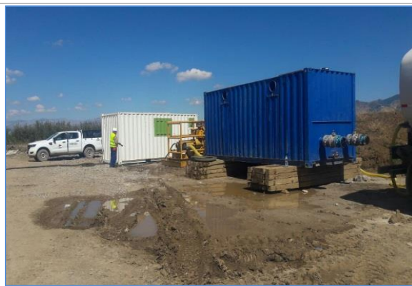
Fig.5.5, Trasportimi i ujit nga depozita e ujit tek stacioni me anë të pompës centrifugale të mbushjes.
