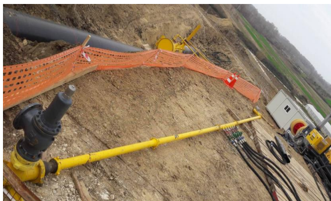
Fig 4.3, Instalimi i valvulës së sigurise
