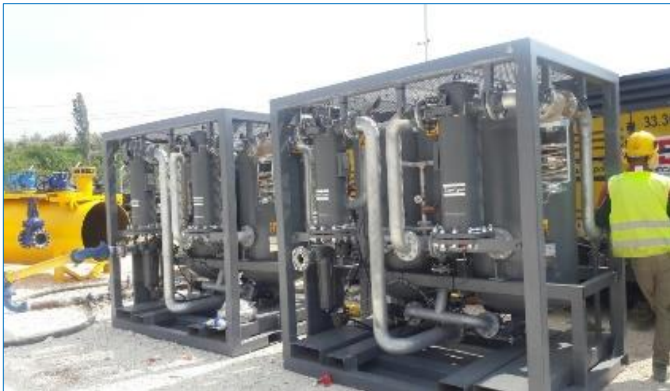
Fig 4.31, Gjatë testimit të pajisjes ne matem vlerën e dew pointit në linjën që montuam dhe arritëm në konkluzionin që dew pointi që arrinte në linje ishte -50^{\circ}\text{C}
