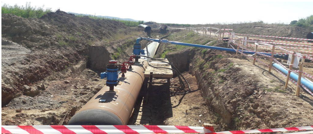
Fig.6.14, Gjatë mbushjes së seksionit me ujë
