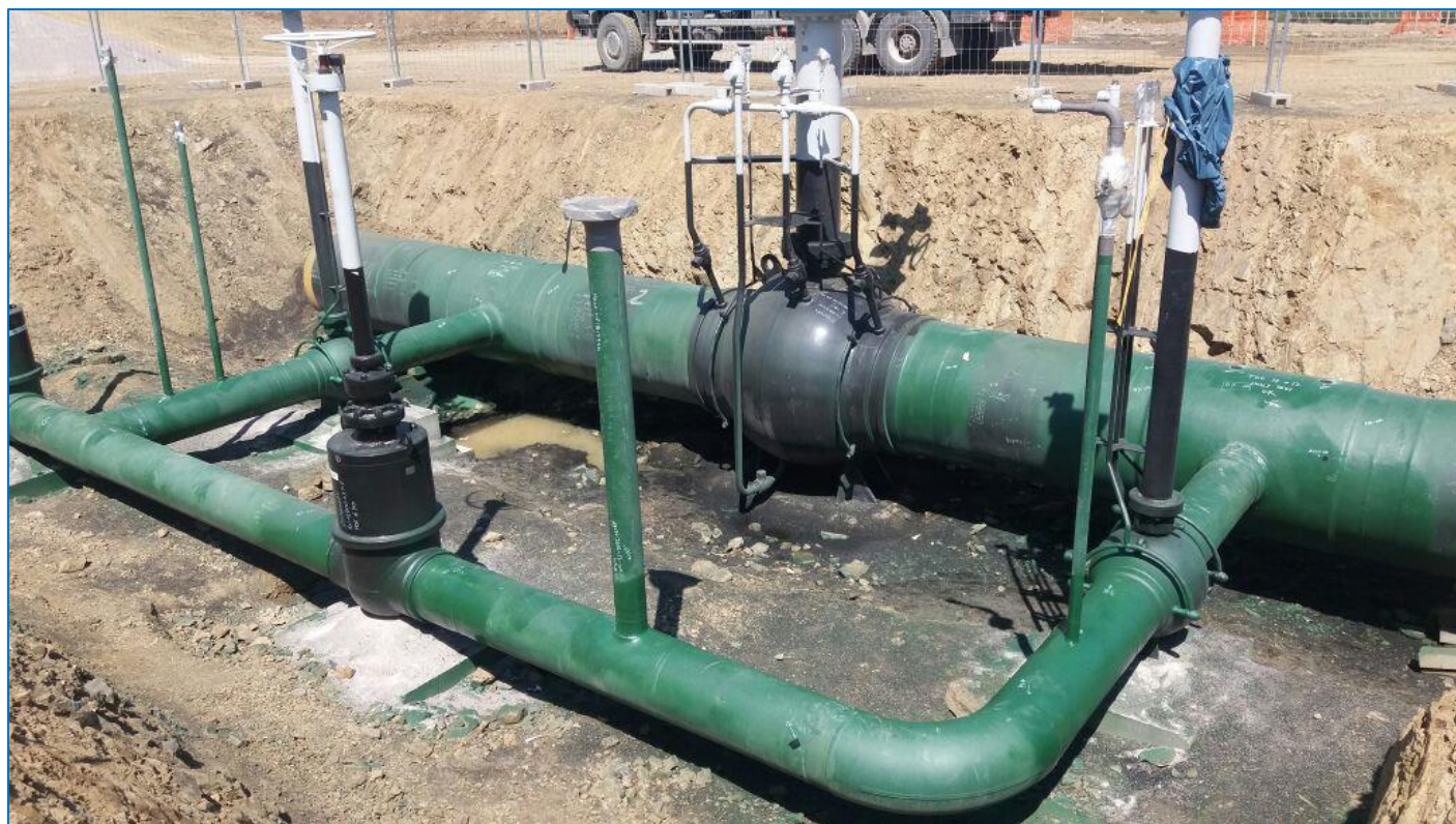
Fig.5.1, Pamje e përgjithshme e stacionit të valvuleve që do të testohet.
