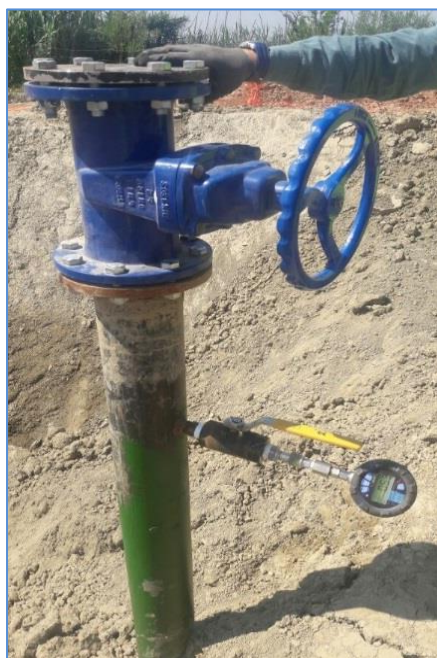
Fig 4.35, instalimi i valvulave dhe injektimi në seksion 0.13 bar
