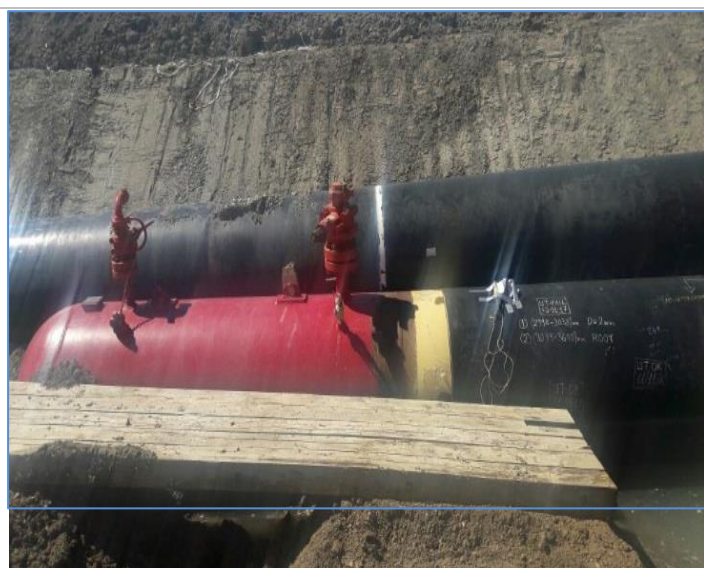
Fig.5.2,Vendosja e termometrave magnet në pjesët e ekspozuara të stacionit për matjen e temperaturës së tubit
