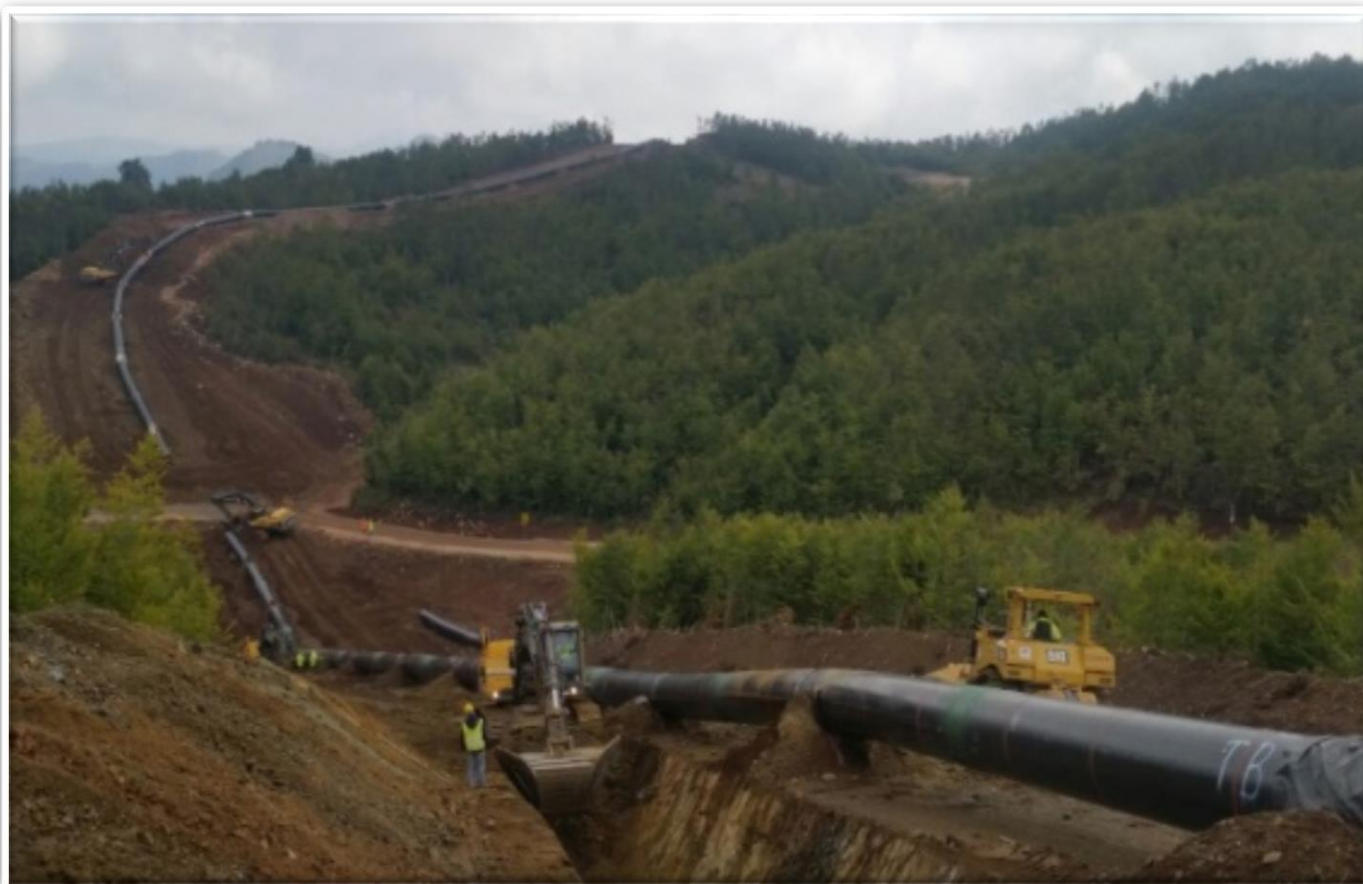
Fig. 2.24, Hapja e kanalit
