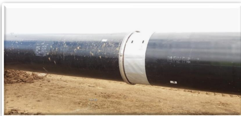
Fig 2.16, Vendosja e mbështjelljes termoizoluese
