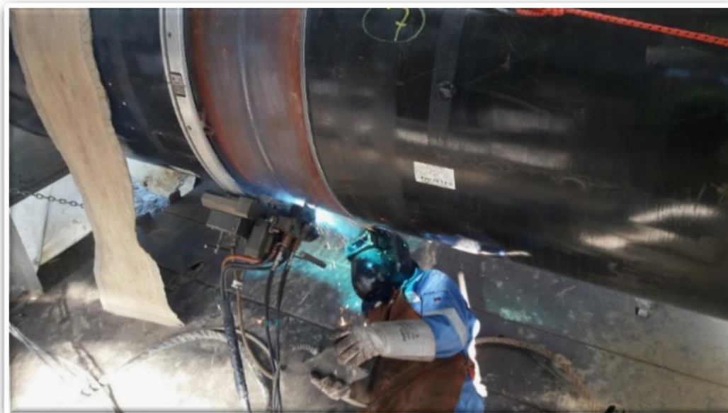
Fig 2.14,Gjatë procesit të saldimit automatik
