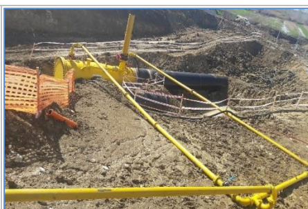
Fig 4.6, Injekti i ajër në seksion para pigut
