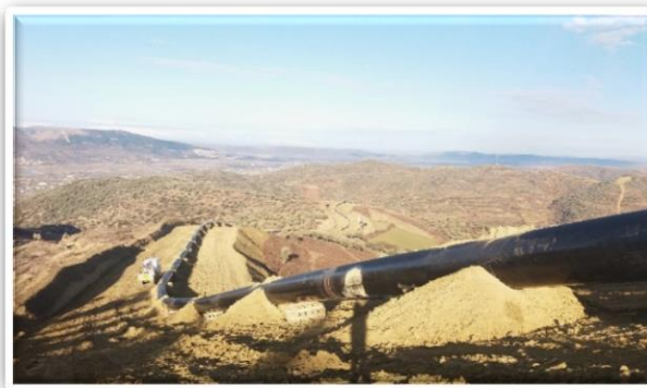
Fig 2.5 Faza pas përfundimit të saldimit
