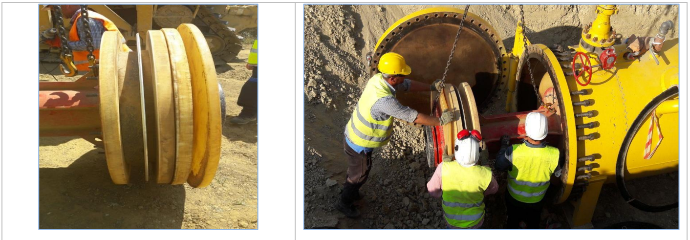
Fig.3.20, Gjatë instalimit dhe futjes së pigut me pllakën e aluminit në tubacion.
