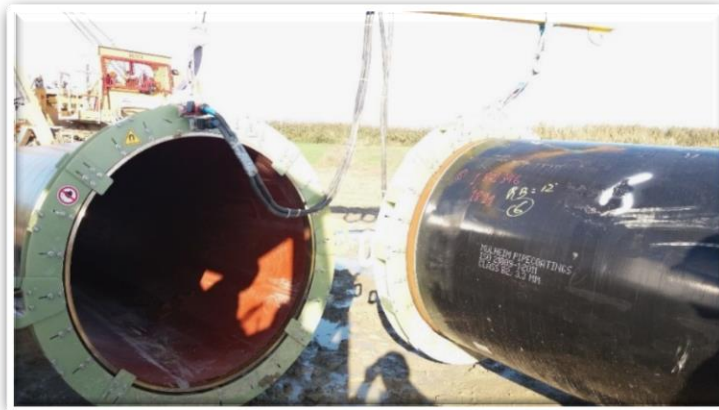
Fig 2.12 ,Parangrohja me ane të induksionit
