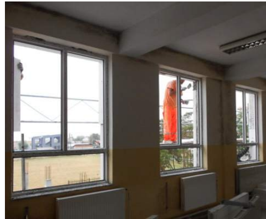
Figure 16. Instalimi i radiatorëve të rinj- pas masave të EE
