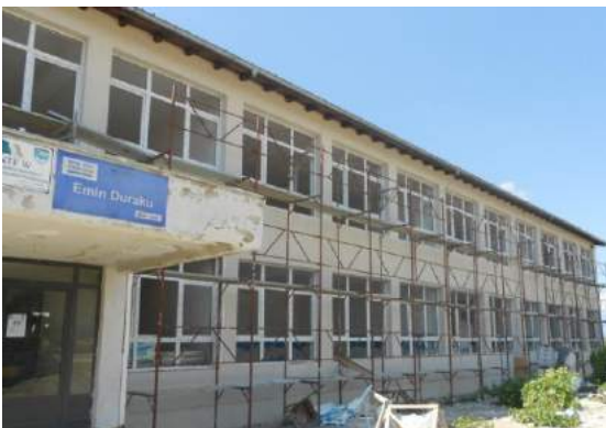
Figure 5: Instalimi i dritareve dhe fasadës nw proces
