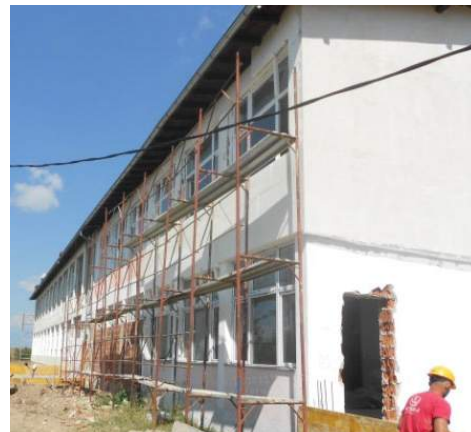
Figure 6: Mbështjellja e fasadës në proces
