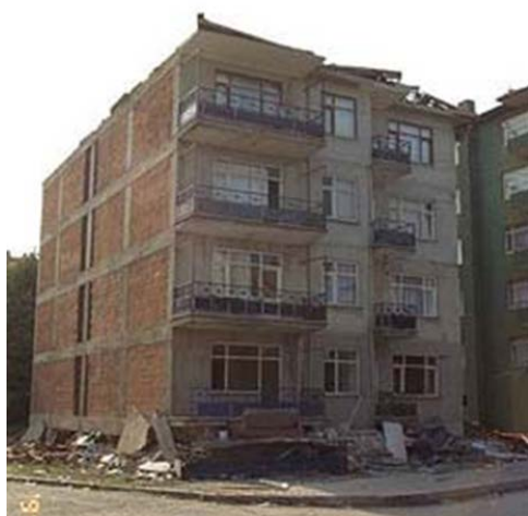
Fig. 1c Struktura e shkatërruar (soft story) në Gölcük
