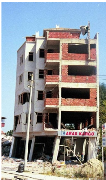
Fig. 1d Struktura e shkatërruar kat I bute (soft story)
