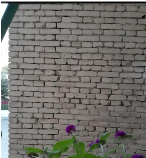
Fig.20. Shkëputje paneli murature mbajtëse, çarje vertikale në muraturë. Godinë 5K me muraturë tulle silicate, Lagjja Kombinat, Tiranë.
