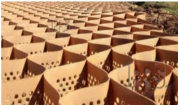
Fig. 2: Pamje ilustruese e gjeogridit Neoweb
