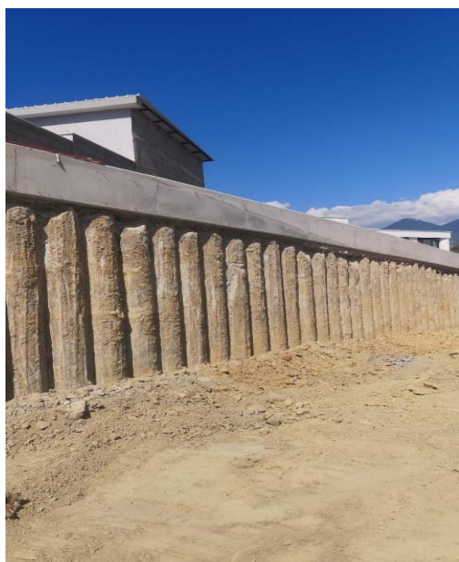
Fig. 11: Perdja e pilotave që ka zvendësuar skarpatat me terramesh.
