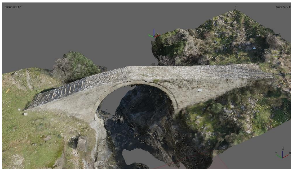
Figura 41 - Modeli 3D i urës së Brarit përftuar nga kombinimi TLS-UAV
