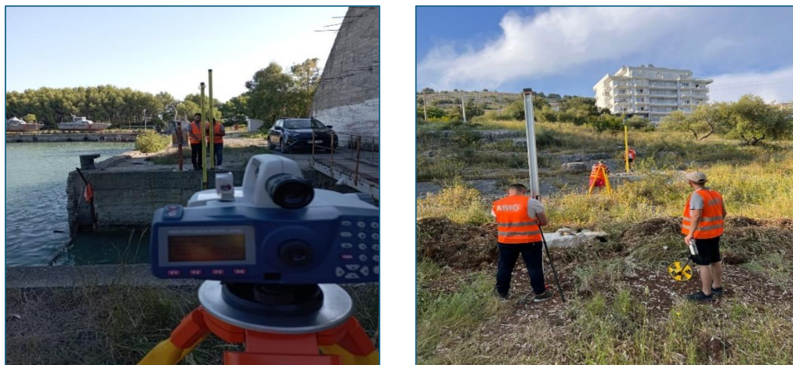
Figura 34 - Foto gjatë matjeve fushore.
